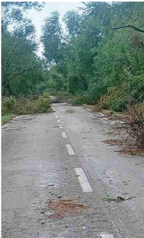
Strage di alberi lungo la Sp 79 Mondonuovo nel Mezzano, che è stata chiusa al traffico
