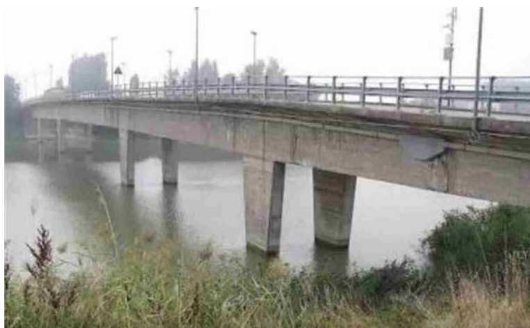
Il ponte sul Cavo Napoleonico, interessato dai lavori sulla struttura, crea problemi al traffico
