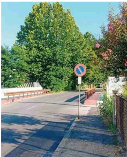
L'obiettivo era la messa in sicurezza di struttura e sponde
