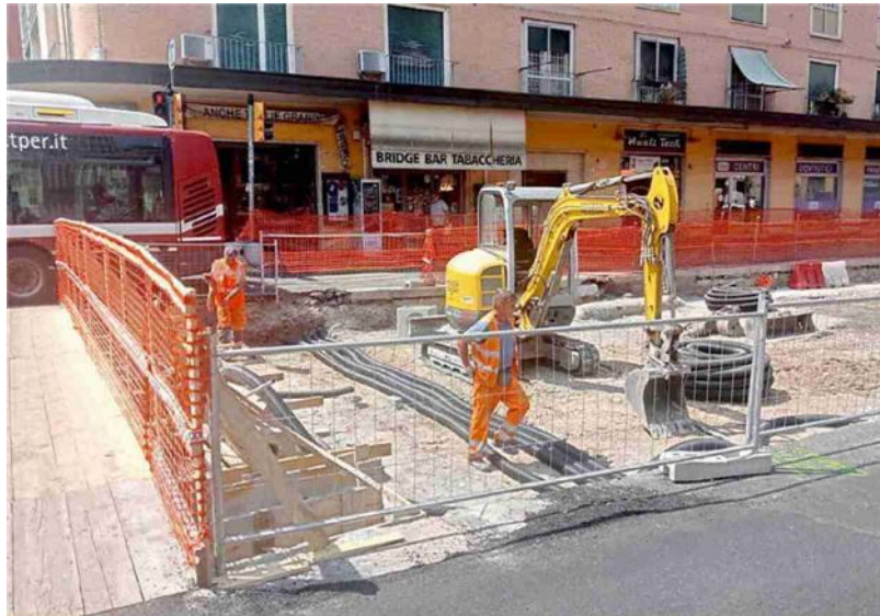
📍 I lavori per la realizzazione del tram
