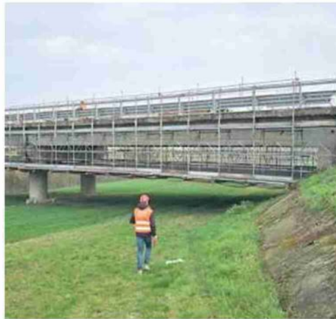
Proseguono i lavori al ponte fra Dosso a Pieve di Cento, da ieri chiuso completamente al traffico
