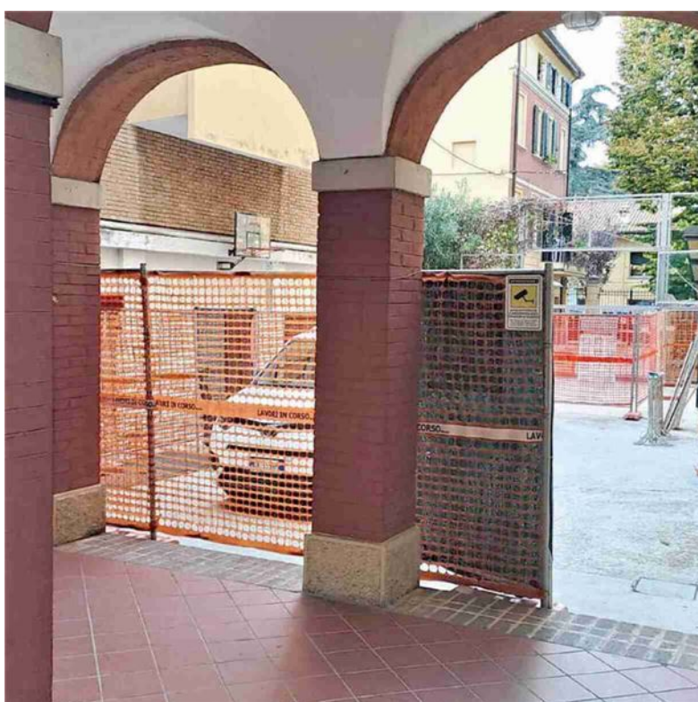
▶ I lavori nel chiostro della chiesa degli Alemanni per 35 posti letto
