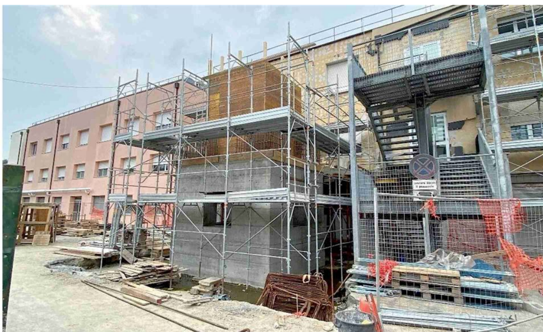
➤ Il cantiere a Bazzano finanziato coi fondi Pnrr
