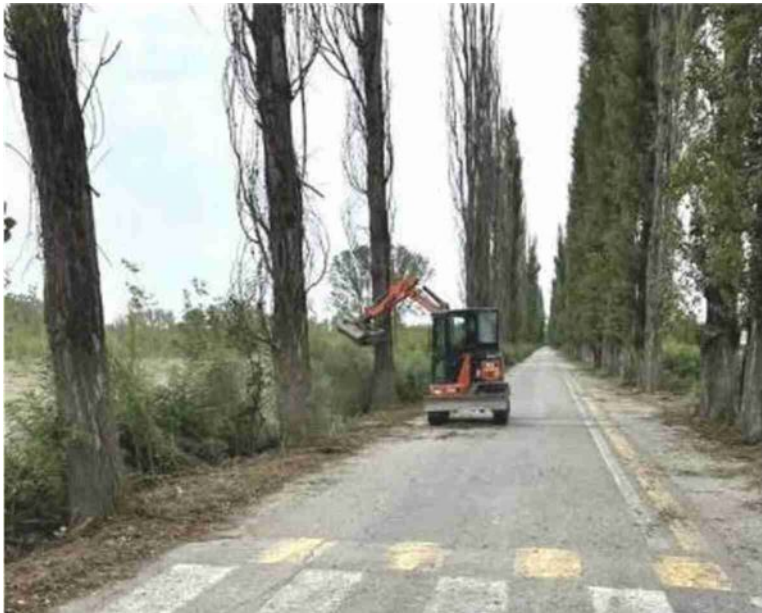
Molti alberi risultano ammalorati, instabili e a rischio caduta
