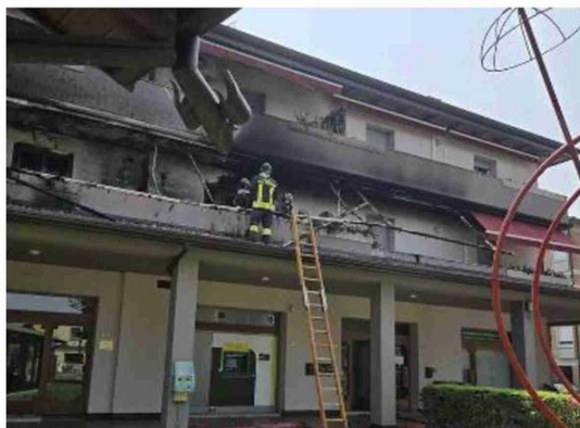
I vigili del fuoco in azione. Il sindaco Erriquez è rimasto leggermente intossicato
