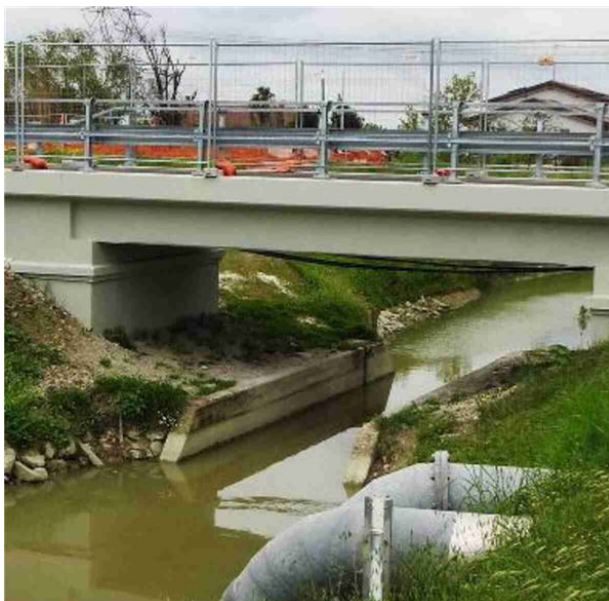
Il ponte sullo scolo consorziale 'Nuovo Tratturo'
