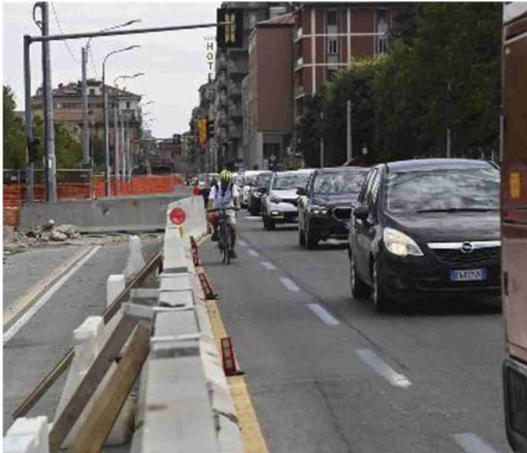
Traffico congestionato in via Saffi a causa dei cantieri del Tram
