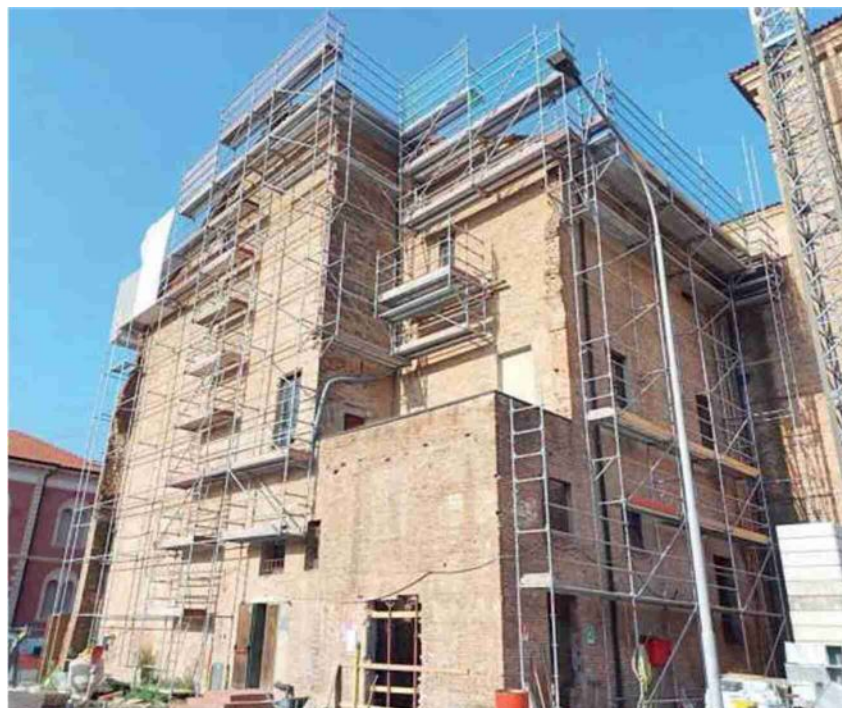
Le impalcature all'esterno di Palazzo Bentivoglio per il cantiere in corso nell'edificio Un altro luogo simbolo di Gualtieri è la piazza per la quale si cercano ora fondi
