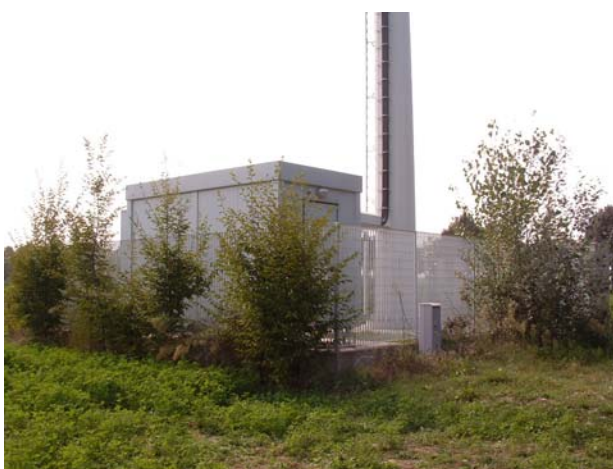
FIG 1: esempio di mitigazione di cabina con siepe di Carpinus betulus . La cabina di colore verde faciliterebbe ulteriormente l'inserimento paesaggistico della stazione radio base.
