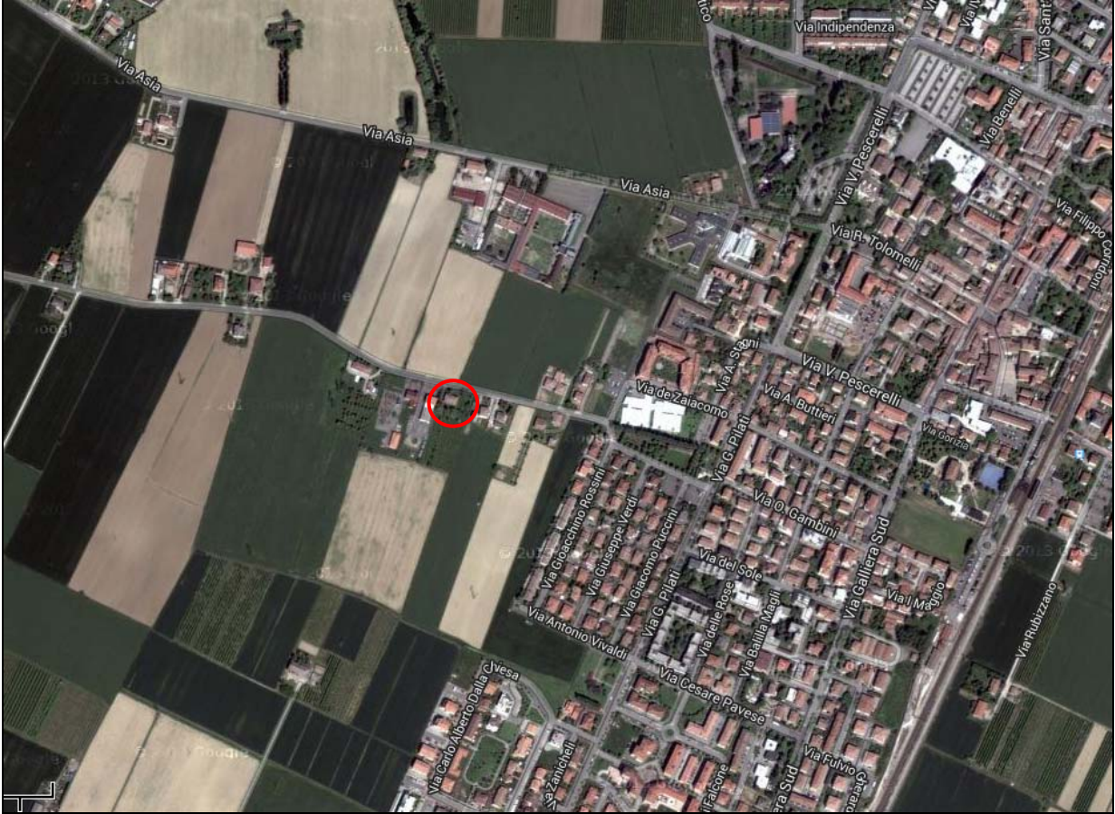
Vista aerea della corte
