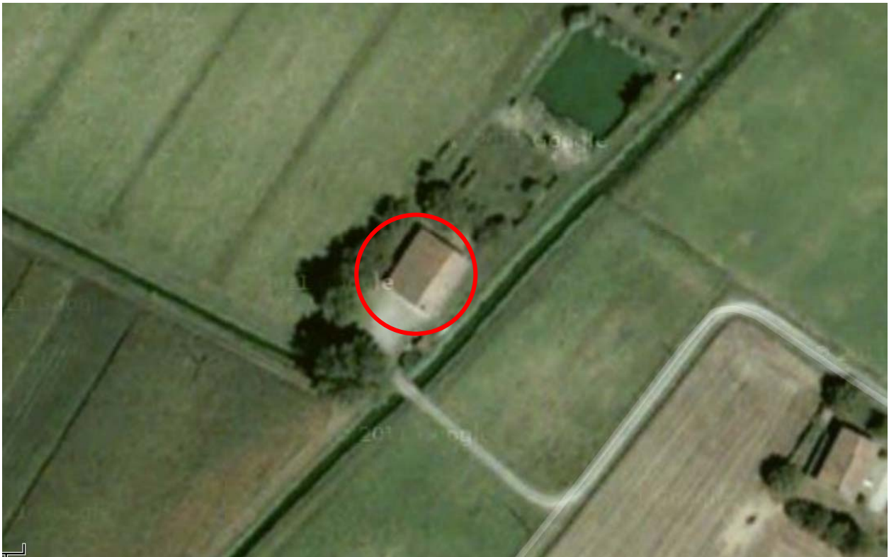
Particolare vista aerea della dell'edificio da delocalizzare
