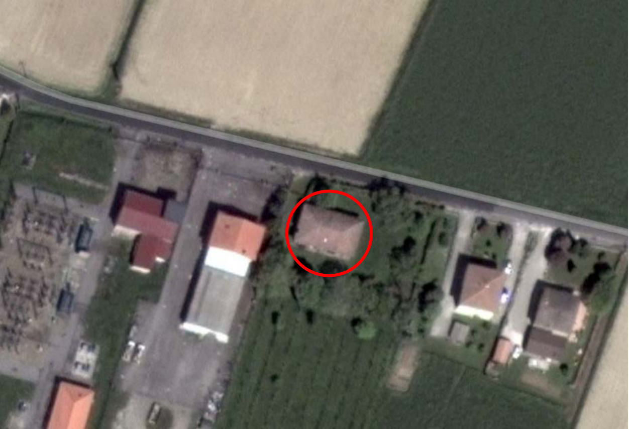
Particolare vista aerea della dell'edificio da delocalizzare
