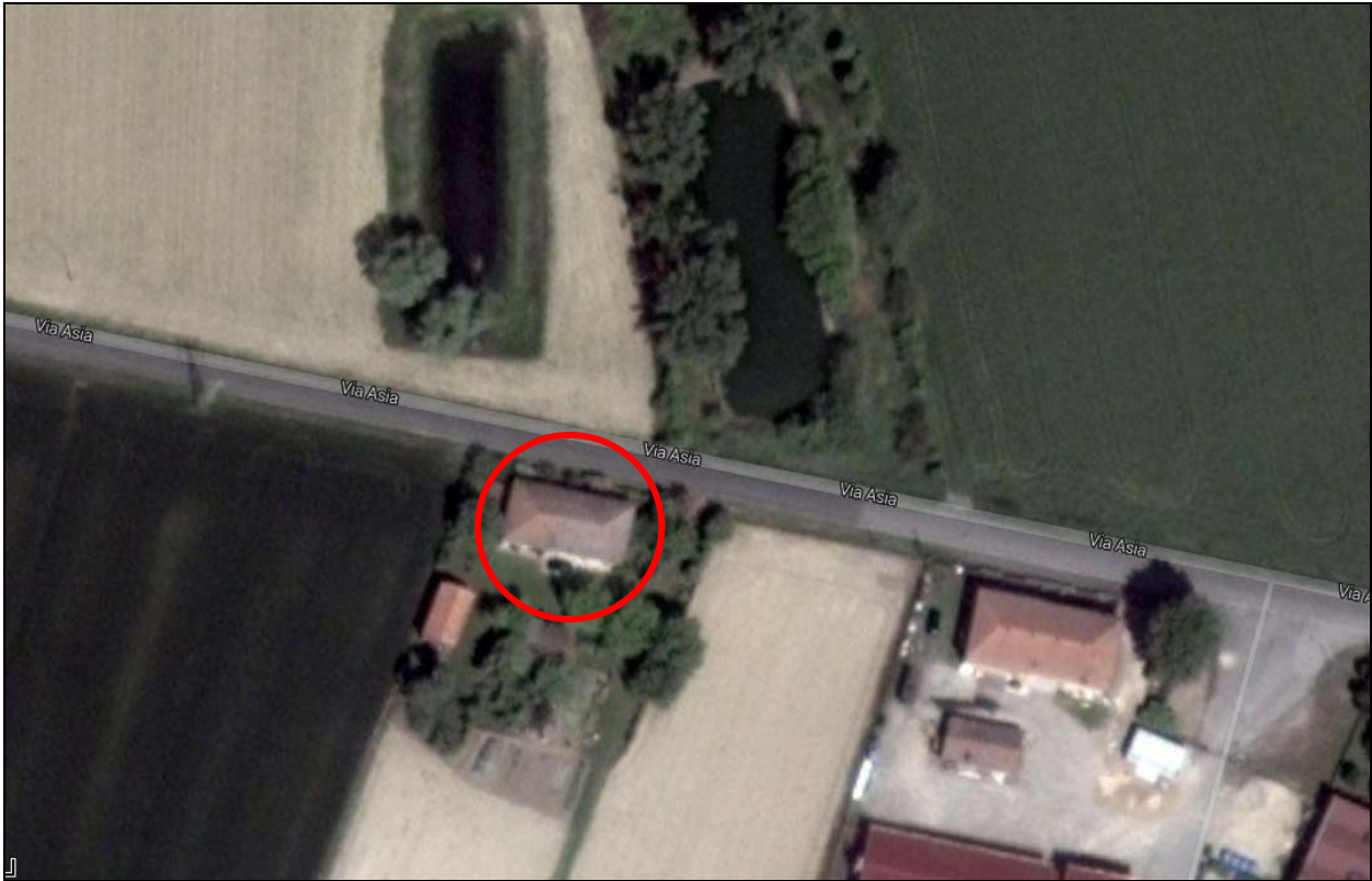
Particolare vista aerea della dell'edificio da delocalizzare
