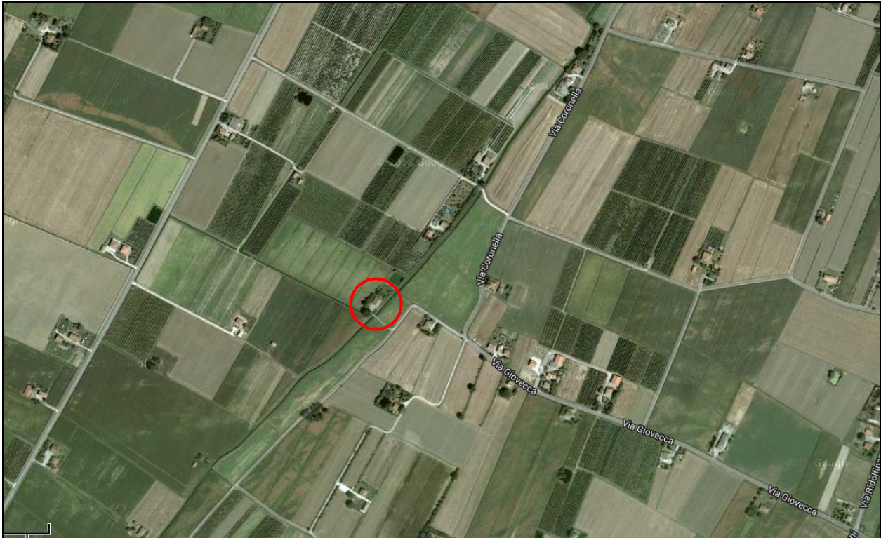
Vista aerea della corte
