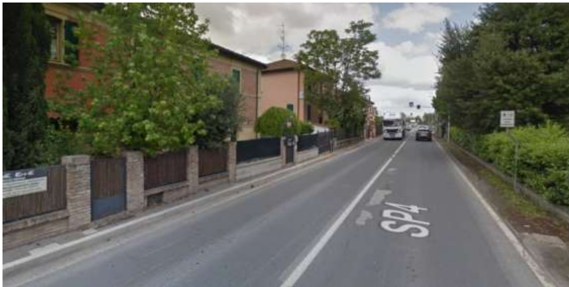
Attraversamento urbano SP 4 Galliera – via Beretta – stato attuale
