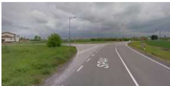
Innesto SP 44 con via Marconi (sulla sinistra stato attuale)
