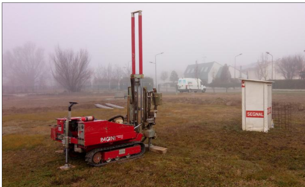
Fotografia 1: Esecuzione della prova penetrometrica statica CPT1.
