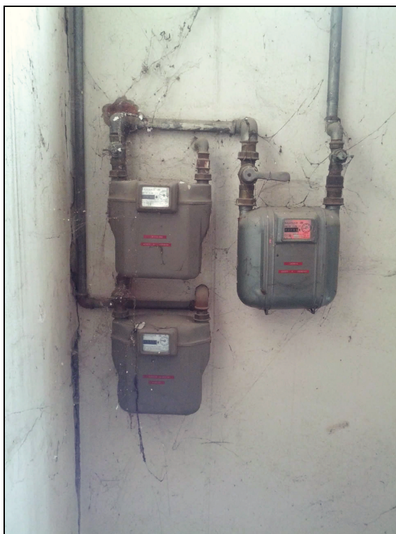
Figura 11 Contatori del gas attualmente installati
