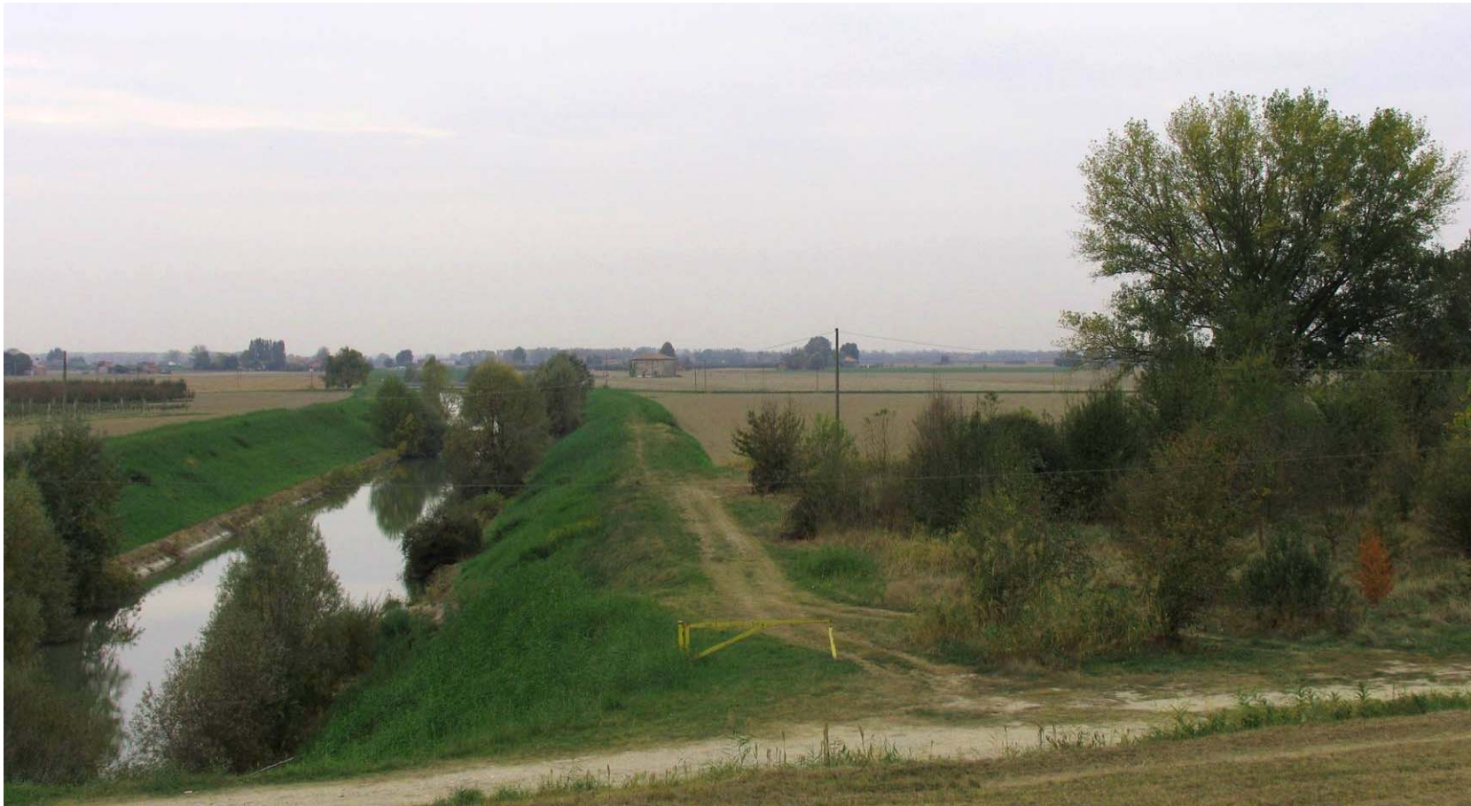
7/I- Canale Emiliano-Romagnolo e cannocchiale visivo verso Sud.
