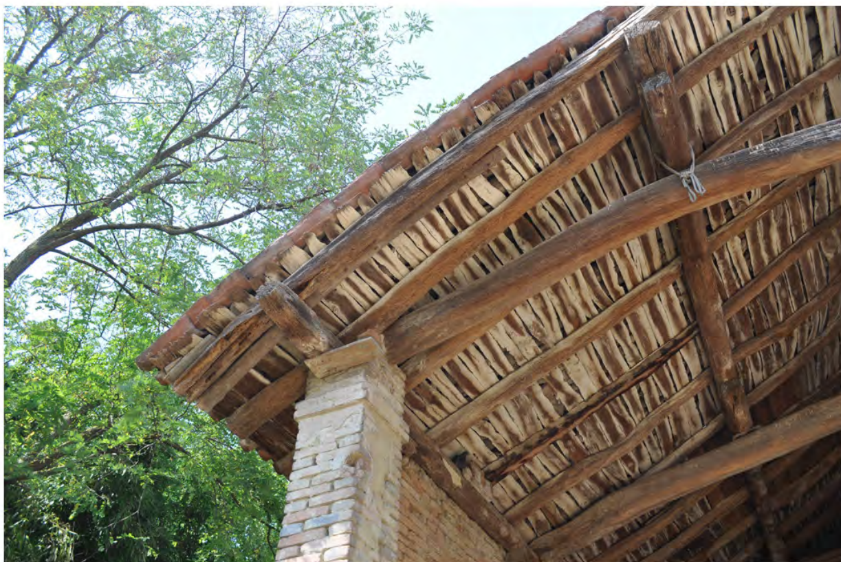
Foto 7. Vista della copertura in legno
