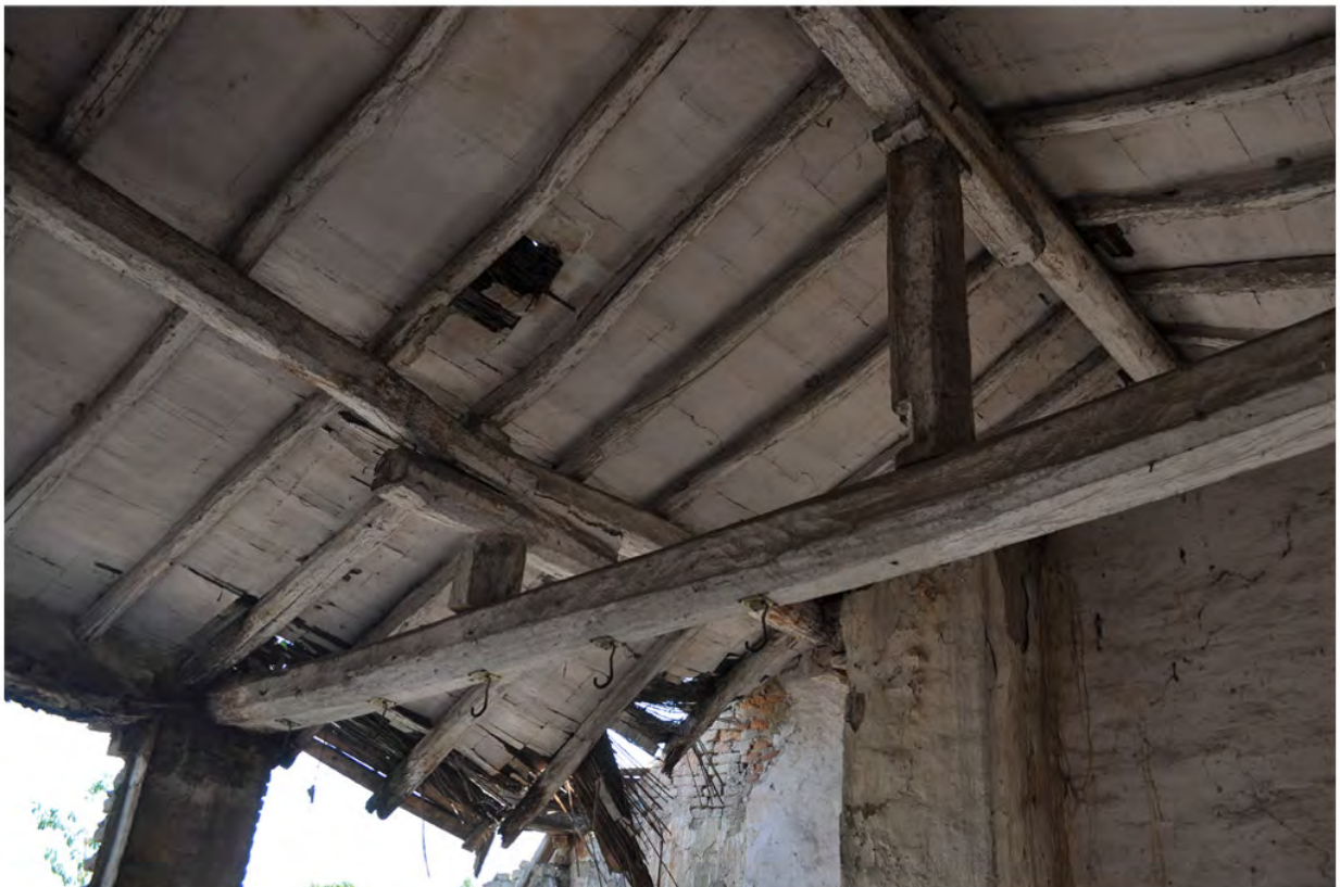
Foto 9. Vista della copertura
