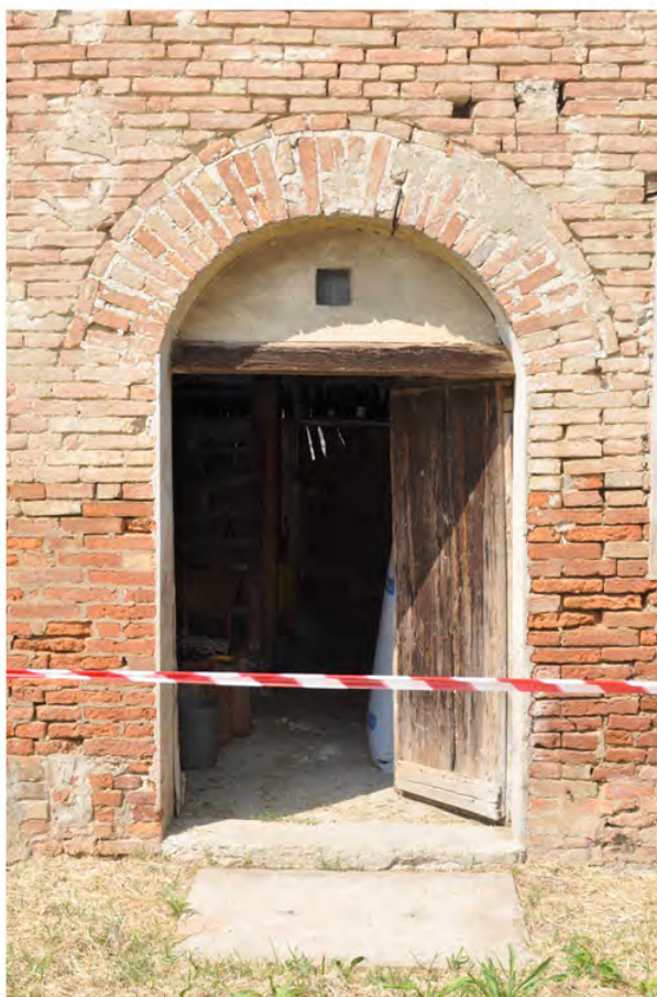
Foto 4. Vista della porta d'ingresso principale
