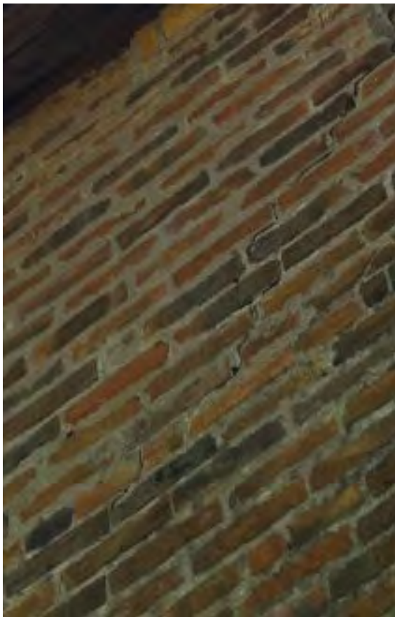
ESEMPIO DI LESIONE CONCENTRATA PASSANTE
