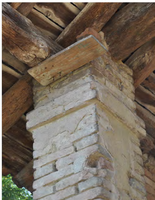
Foto 6. Vista di un particolare del pilastro
