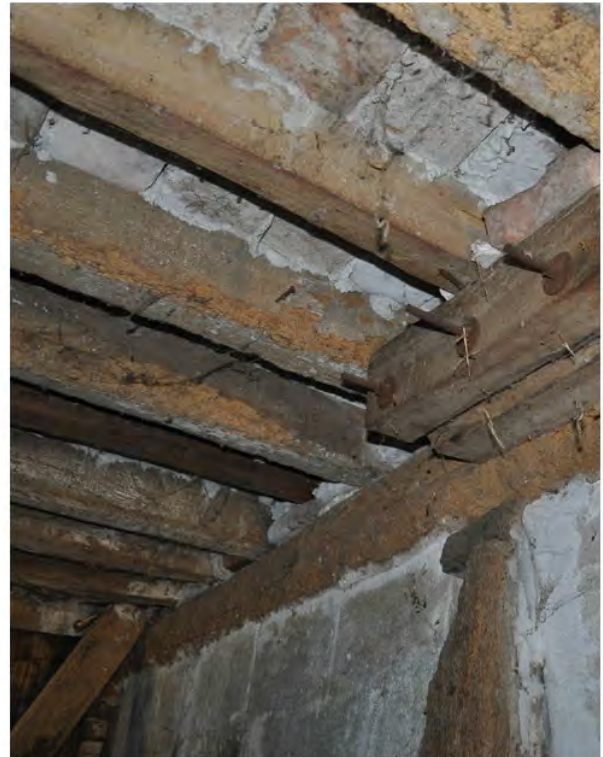
Foto 8. Vista del solaio interpiano
