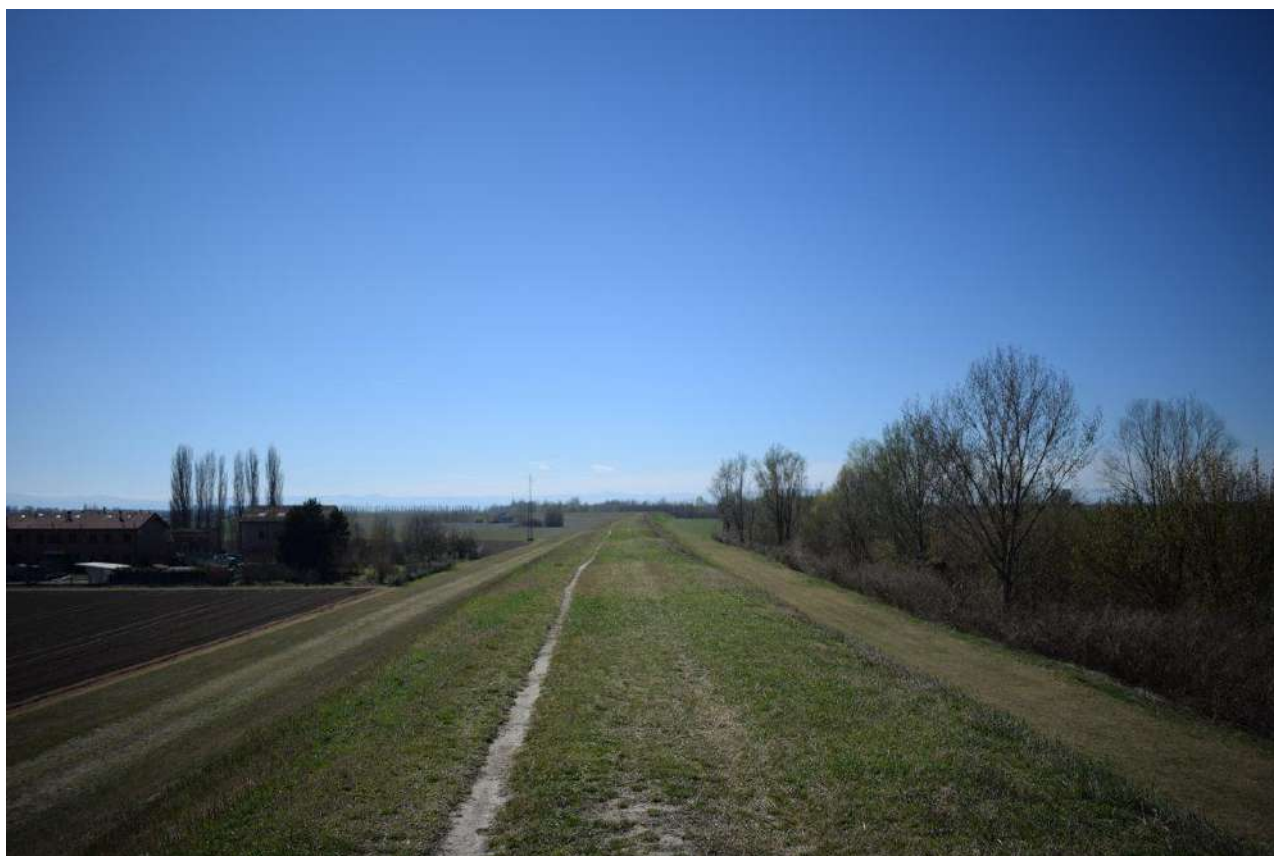
Vista di tratto tipico del rilevato arginale oggetto dei lavori per la realizzazione della ciclovia.
