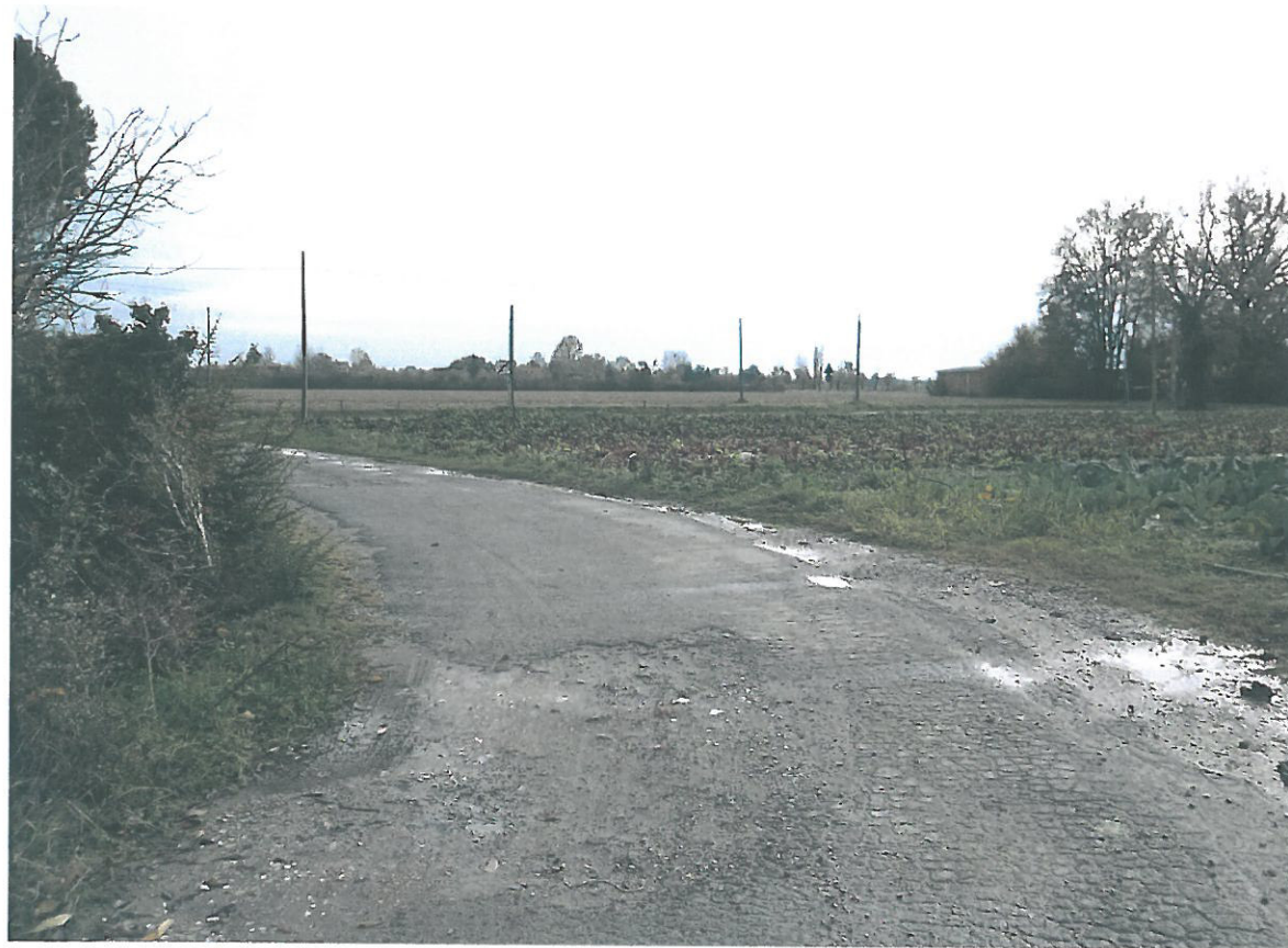
Vista accesso da Via San Marina
