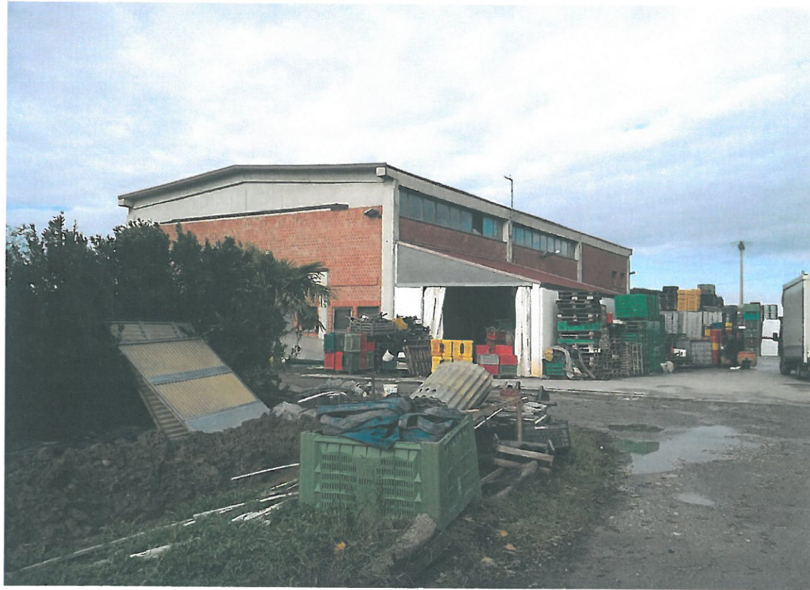
Vista Fabbricato principale – Magazzino Agricolo – Vista Sud/Est
