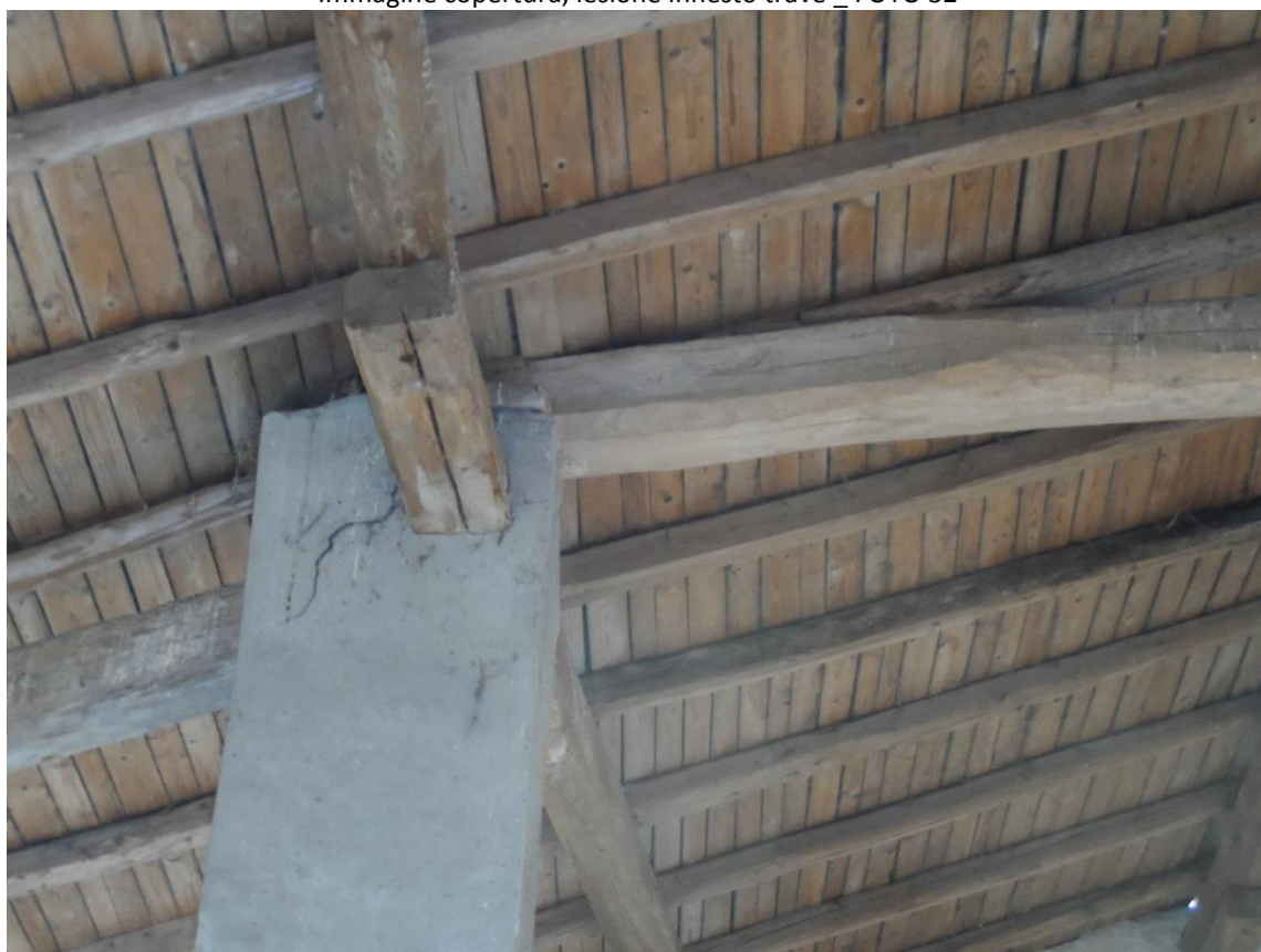
Immagine copertura, lesione innesto trave_ FOTO 32
