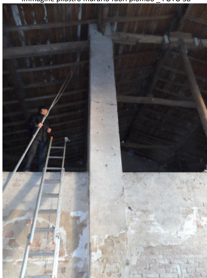
Immagine pilastro murario fuori piombo _ FOTO 38
