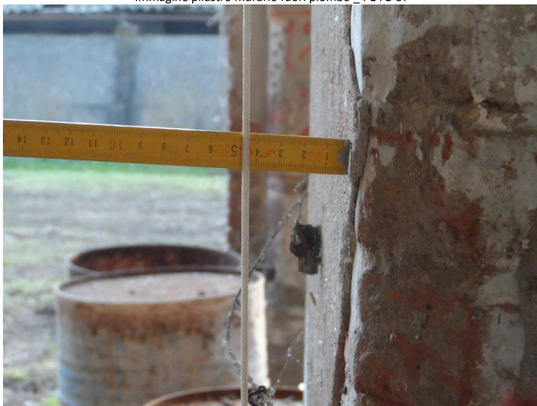
Immagine pilastro murario fuori piombo _ FOTO 38
