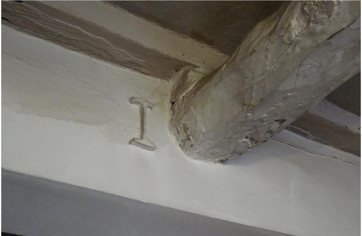
Foto 9- Particolare dell'innesto di travi IPE su muro portante
