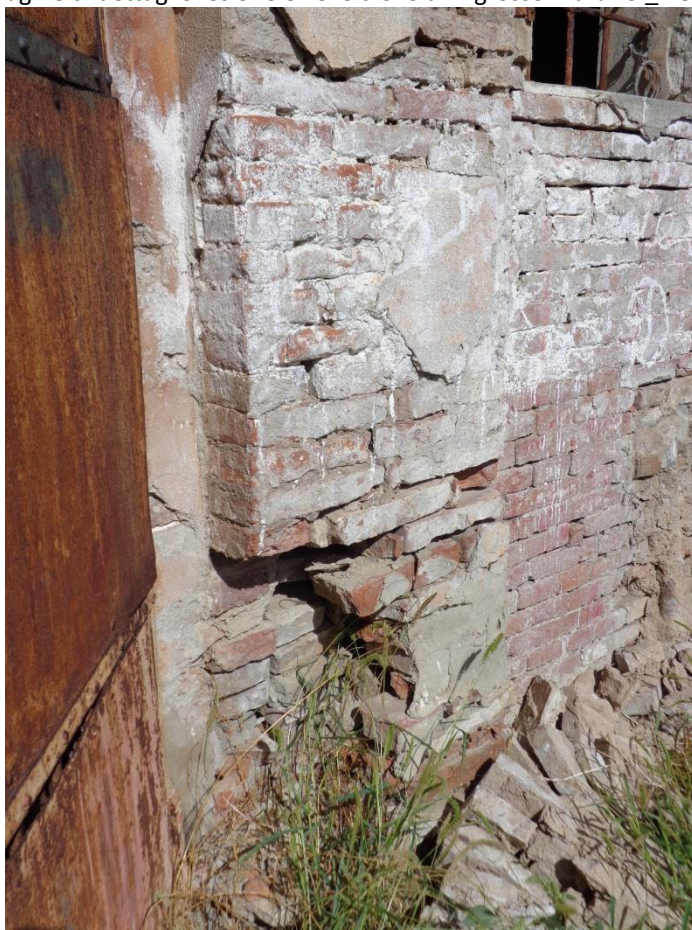
Immagine di dettaglio scivolamento manto, con pericolo di caduta_ FOTO 4
