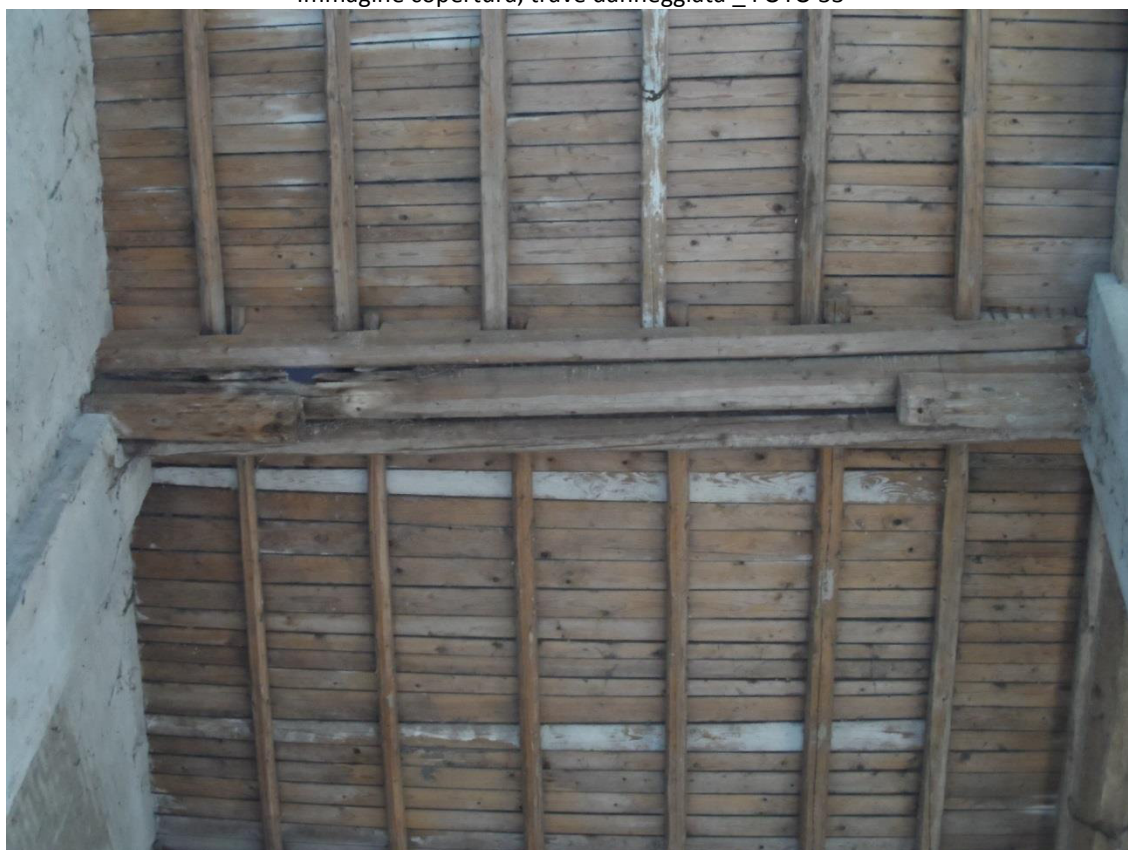
Immagine copertura, lesione innesto trave _ FOTO 34
