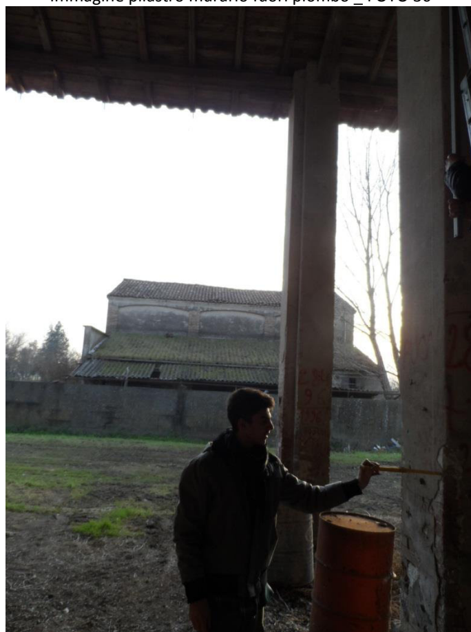
Immagine pilastro murario fuori piombo _ FOTO 36
