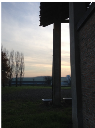
Edificio “casella” – ad uso tettoia.
