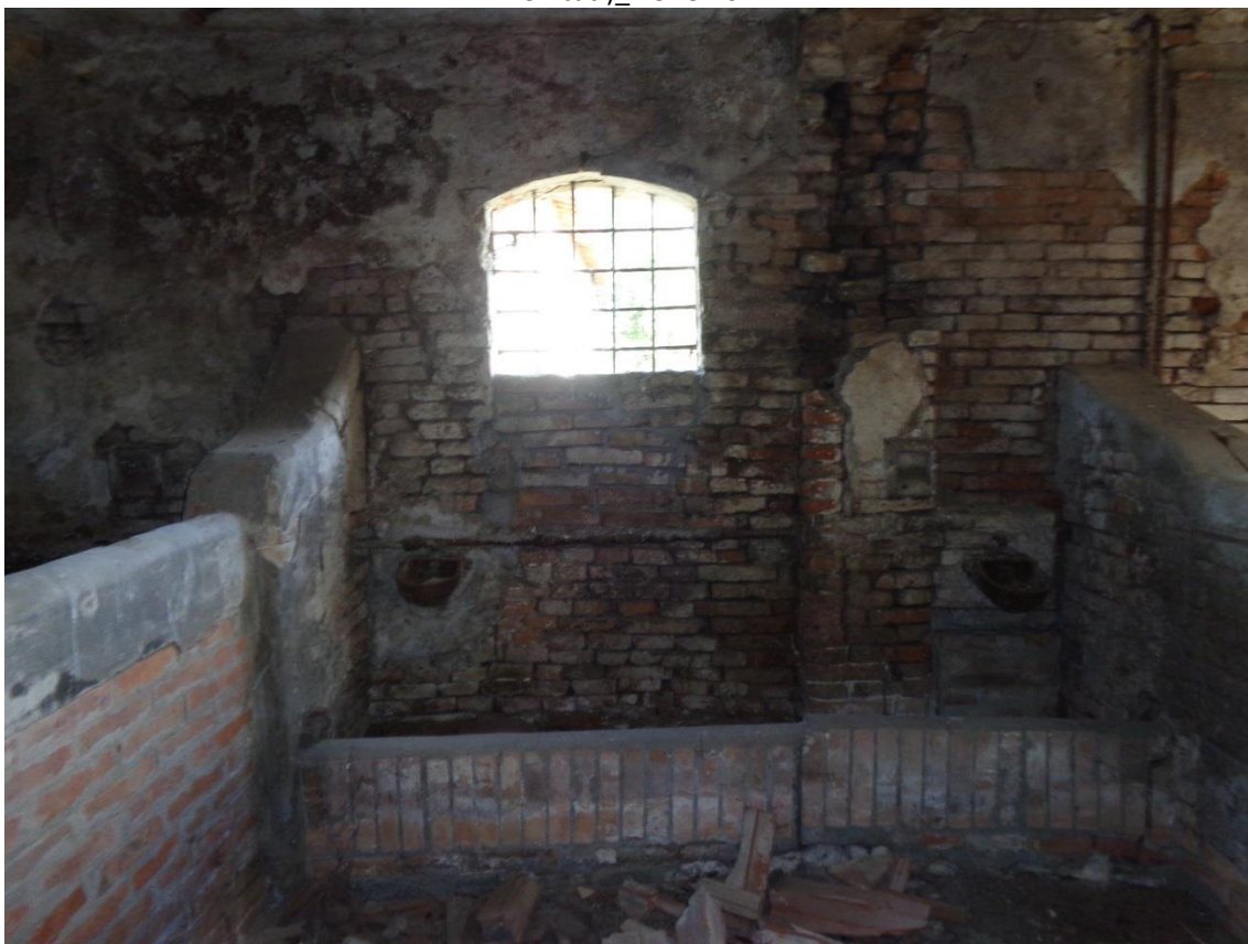
Immagine interna, dettaglio consistenza muraria (malta povera di cemento e giunti assottigliati e non pienamente efficaci)_ FOTO 20
