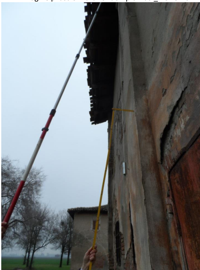
Immagine pilastro murario fuori piombo _ FOTO 40
