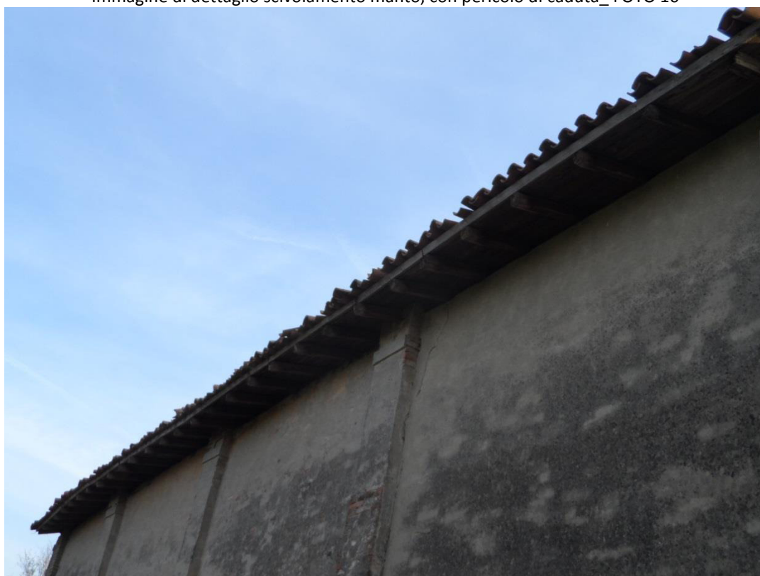
Immagine di dettaglio scivolamento manto, con pericolo di caduta_ FOTO 10
