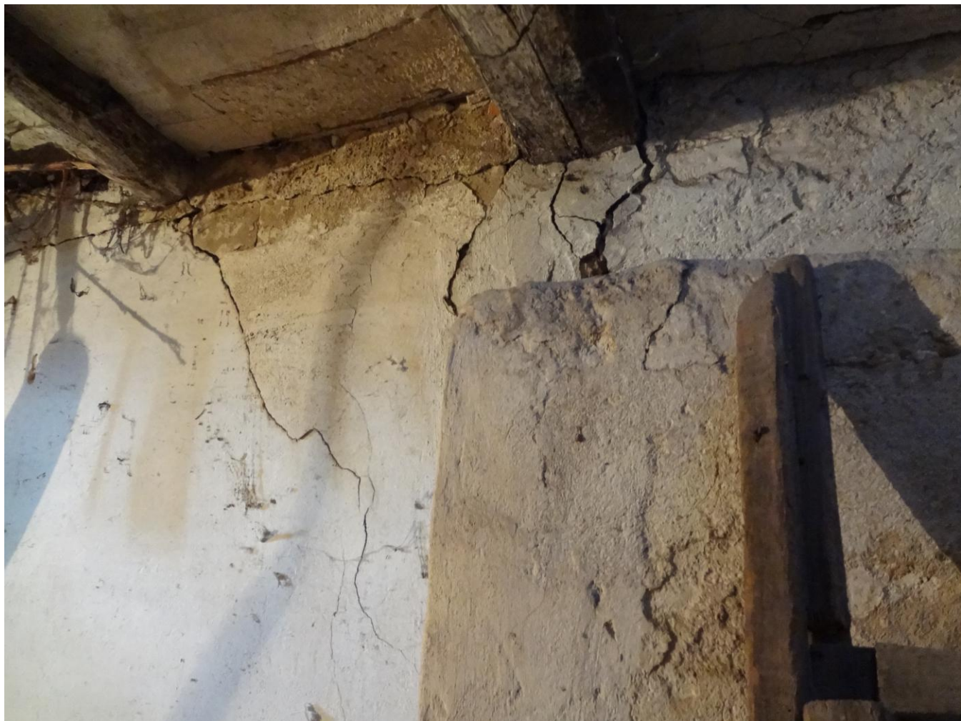
Foto 42 – martellamento degli elementi costruttivi con espulsione del materiale.
