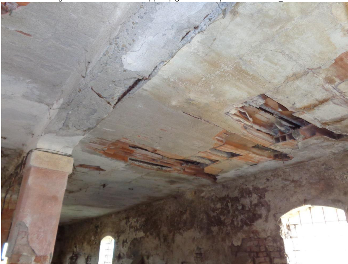
Immagine solaio con lesioni e scoppi di pignatta in campate corte laterali_ FOTO 18
