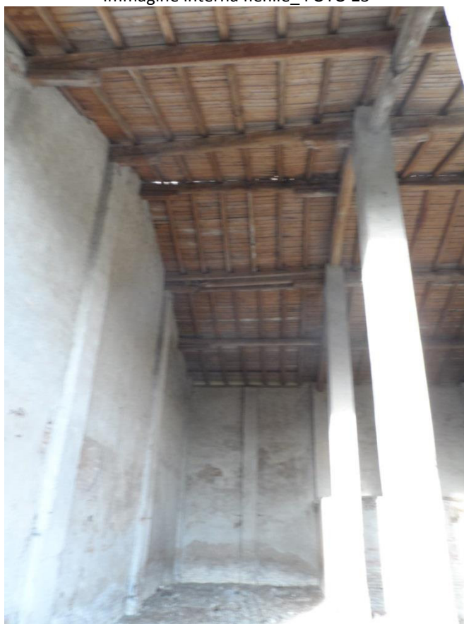
Immagine di dettaglio sconnessione ringrosso murario a parete_ FOTO 24
