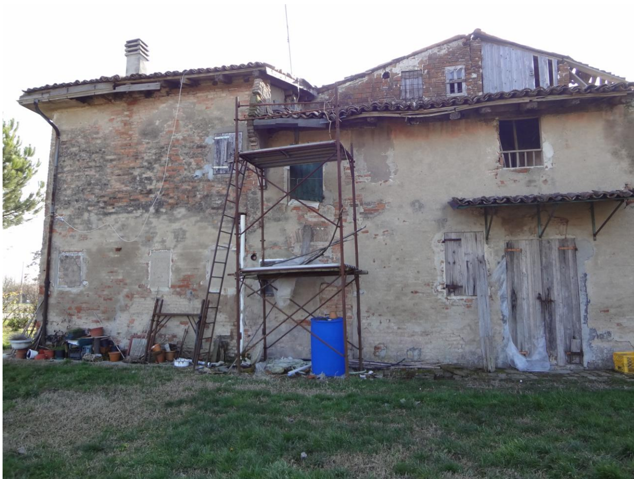
Foto 5- Vista del lato Nord-Est del fabbricato
