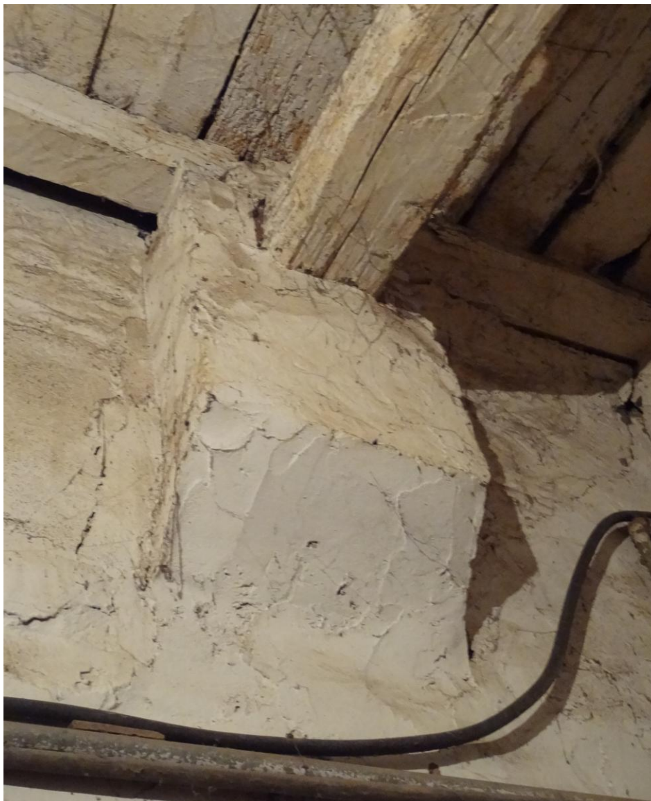
Foto 15 – l'immagine ritrae la parte iniziale di un pilastro che prosegue anche al piano primo che sorregge parte della copertura.
