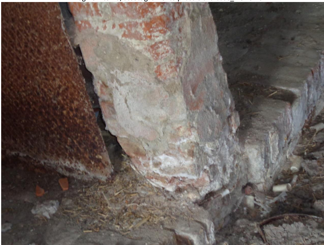
Immagine interna, dettaglio consistenza muraria (malta povera di cemento e giunti assottigliati e non pienamente efficaci)_ FOTO 20
