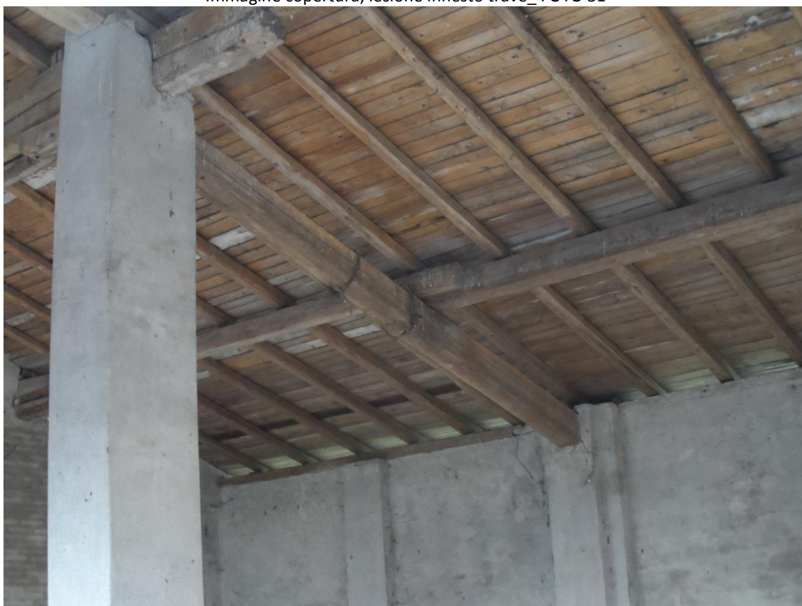
Immagine copertura, lesione innesto trave_ FOTO 32
