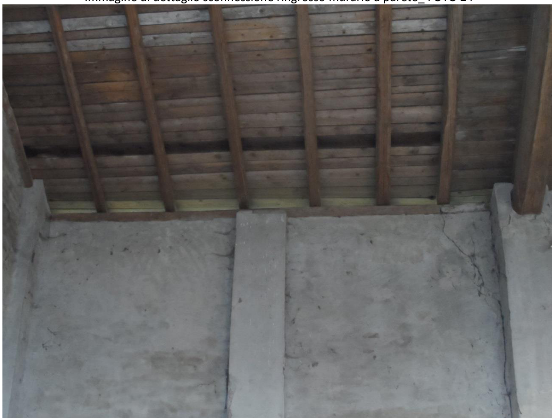
Immagine di dettaglio sconnessione ringrosso murario a parete_ FOTO 24
