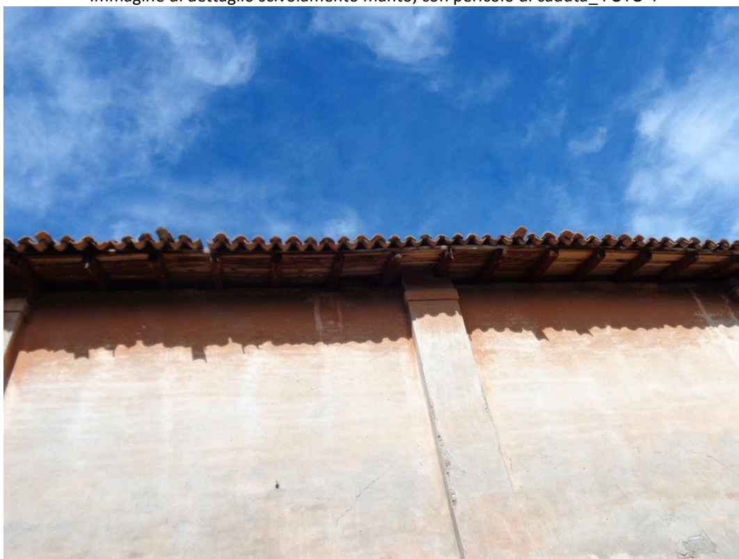
Immagine di dettaglio scivolamento manto, con pericolo di caduta_ FOTO 4
