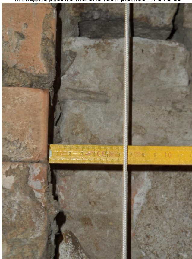
Immagine pilastro murario fuori piombo _ FOTO 40
