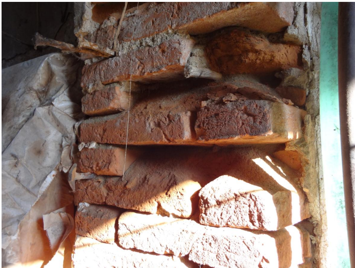
Foto 25 – Malta friabile facilmente removibile a mano.
