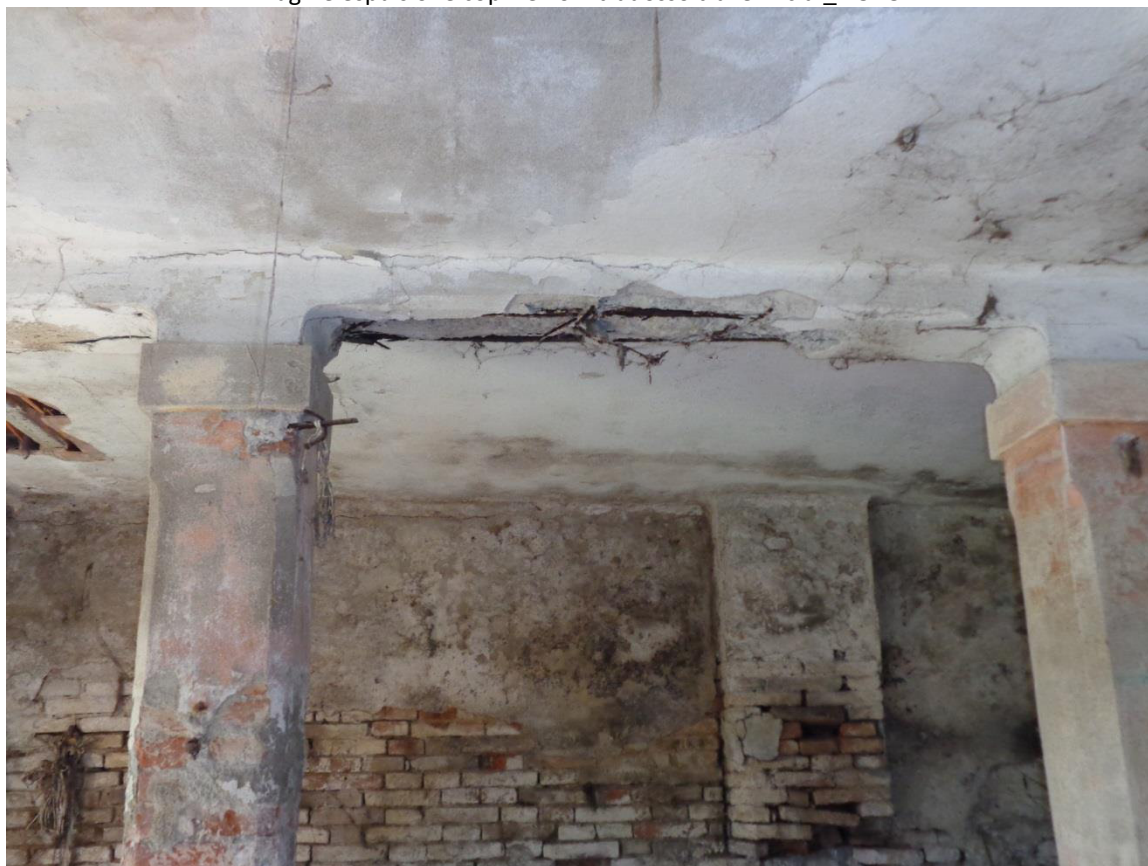
Immagine solaio con lesioni e scoppi di pignatta in campate corte laterali_ FOTO 18
