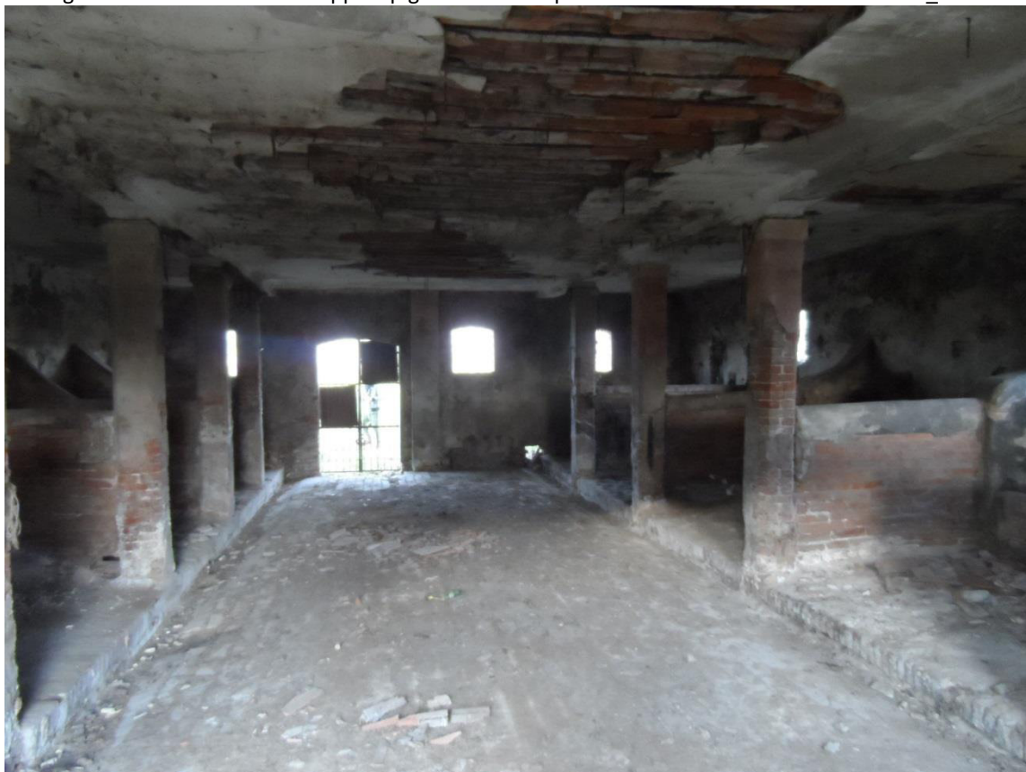
Immagine solaio con lesioni e scoppi di pignatta in corrispondenza della mezzeria in intradosso_ FOTO 16
