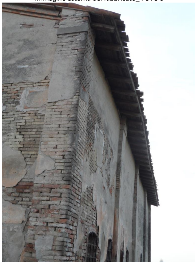
Immagine di dettaglio scivolamento manto, con pericolo di caduta_ FOTO 10
