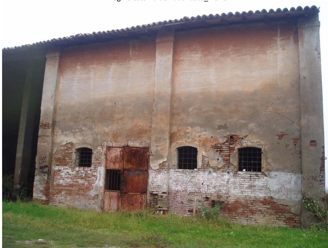
Immagine di dettaglio lesioni in corrispondenza aperture_ FOTO 2
