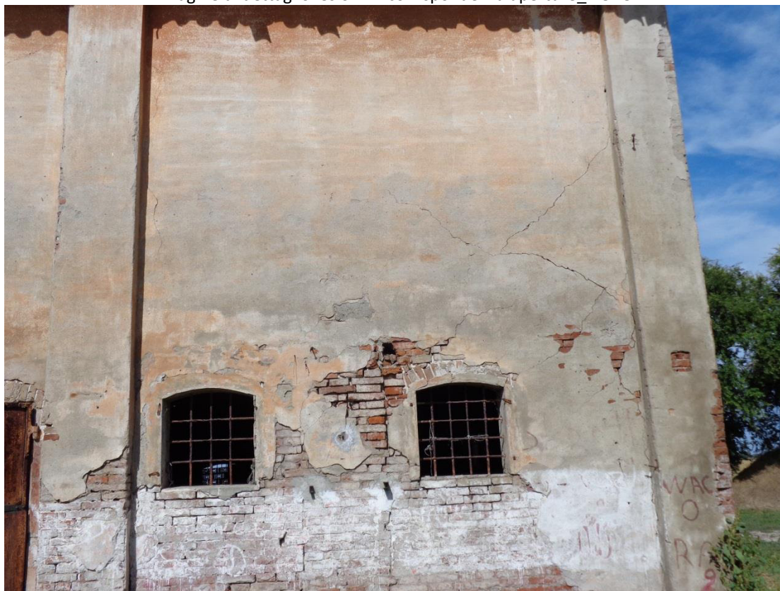
Immagine di dettaglio lesioni in corrispondenza aperture_ FOTO 2
