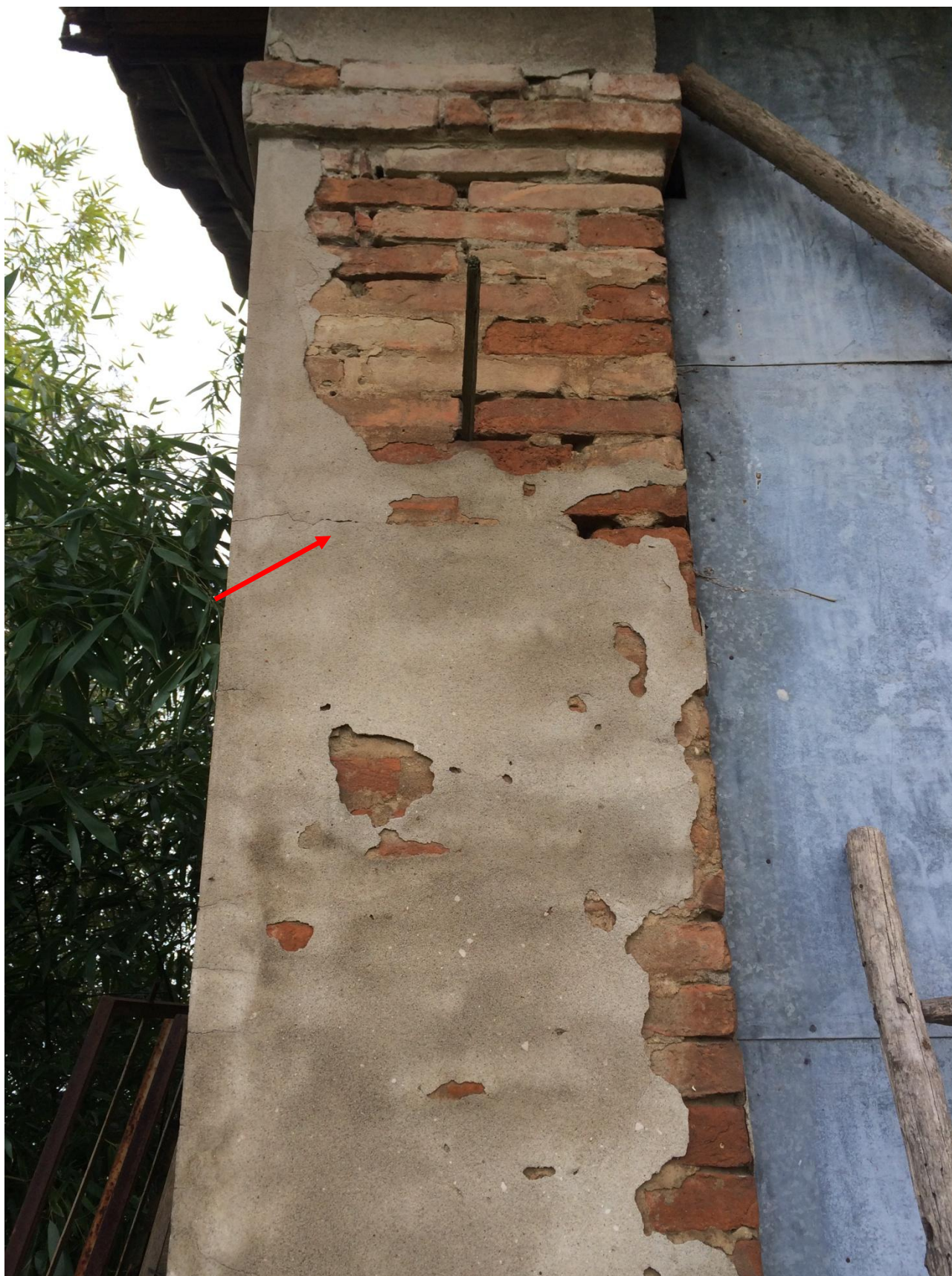
Fig. 23 – Taglio orizzontale del pilastro d'angolo
