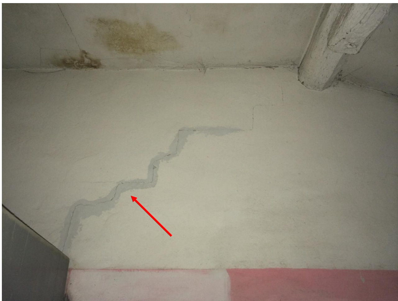
Fig. 50 – Lesione diagonale
