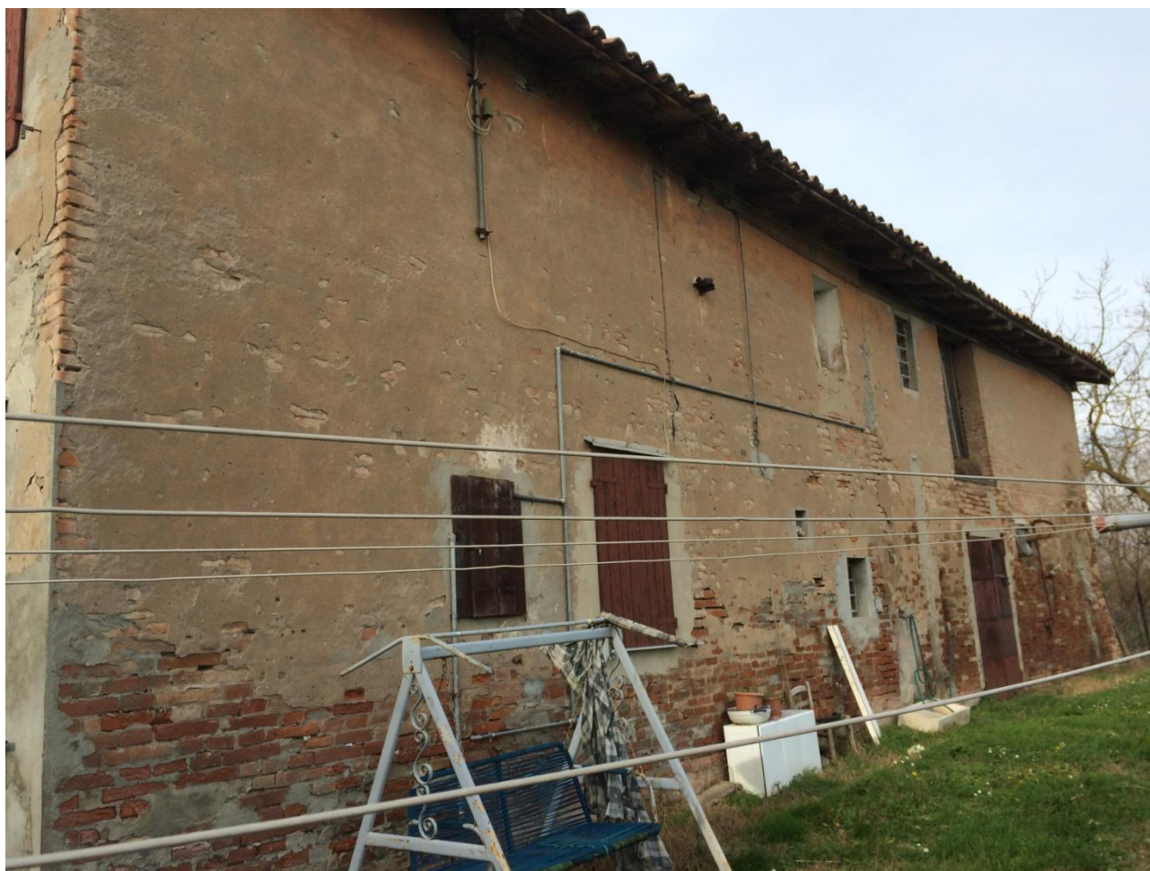
Fig. 11 – Vista della facciata est
