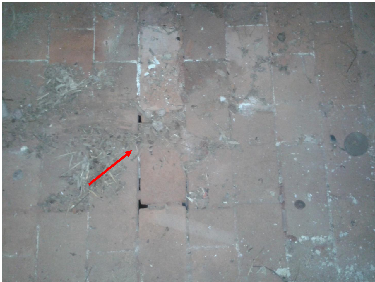
Fig. 50 – Spostamento dei travetti e delle tavelle di solaio di piano primo
