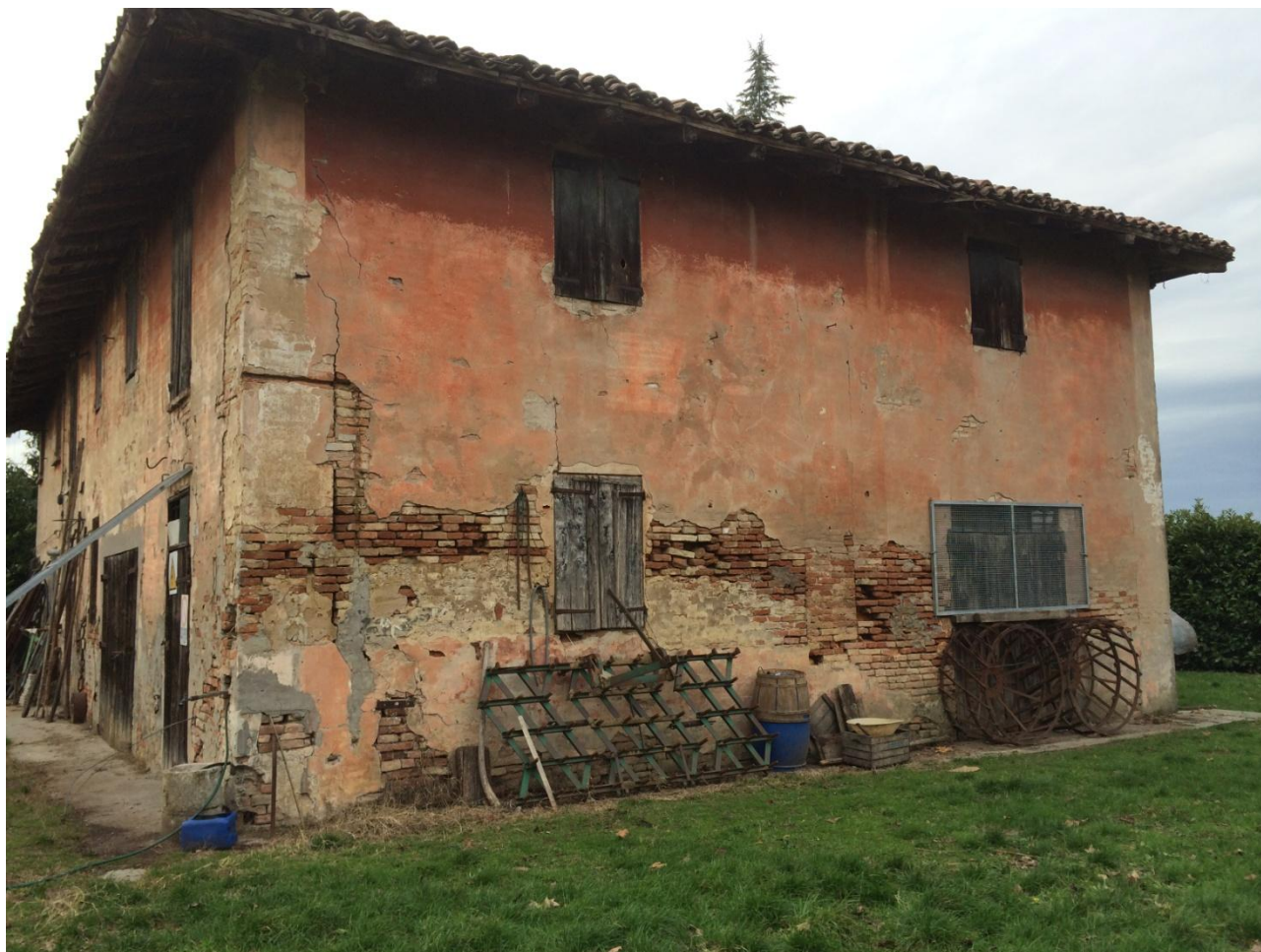
Fig. 16 - Vista della facciata est
