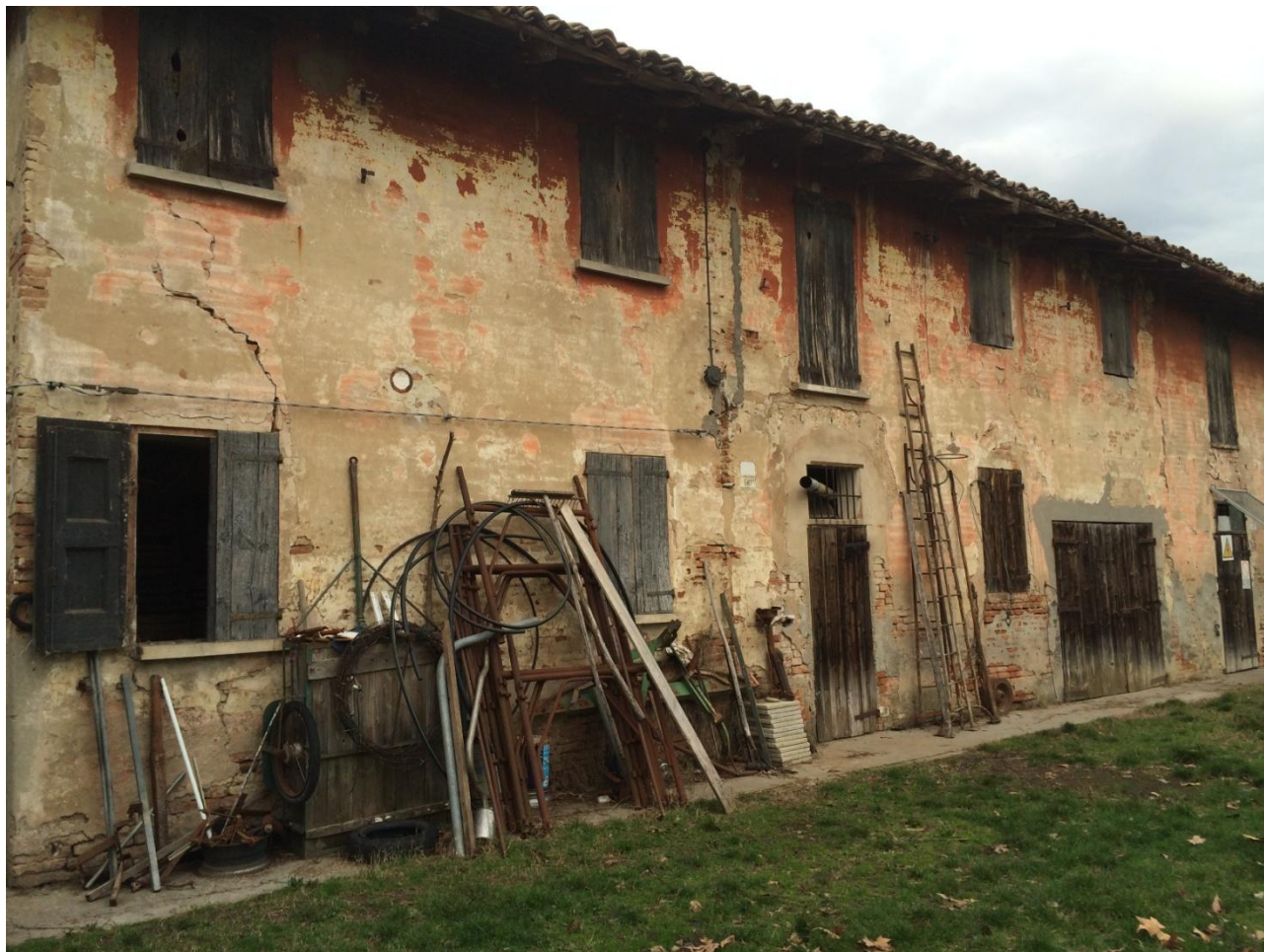
Fig. 7 - Vista della facciata sud
