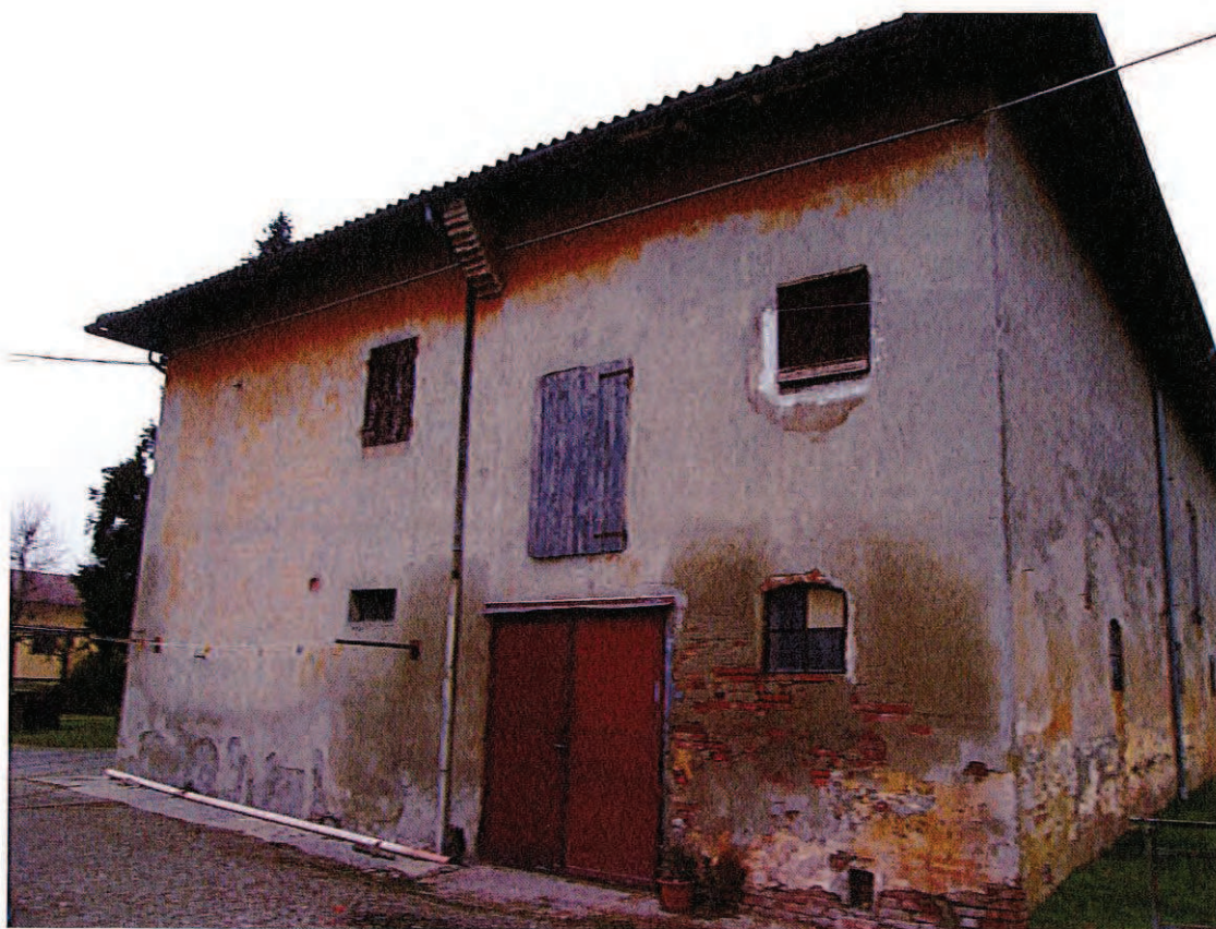
Foto E14-prospetto sud-est
