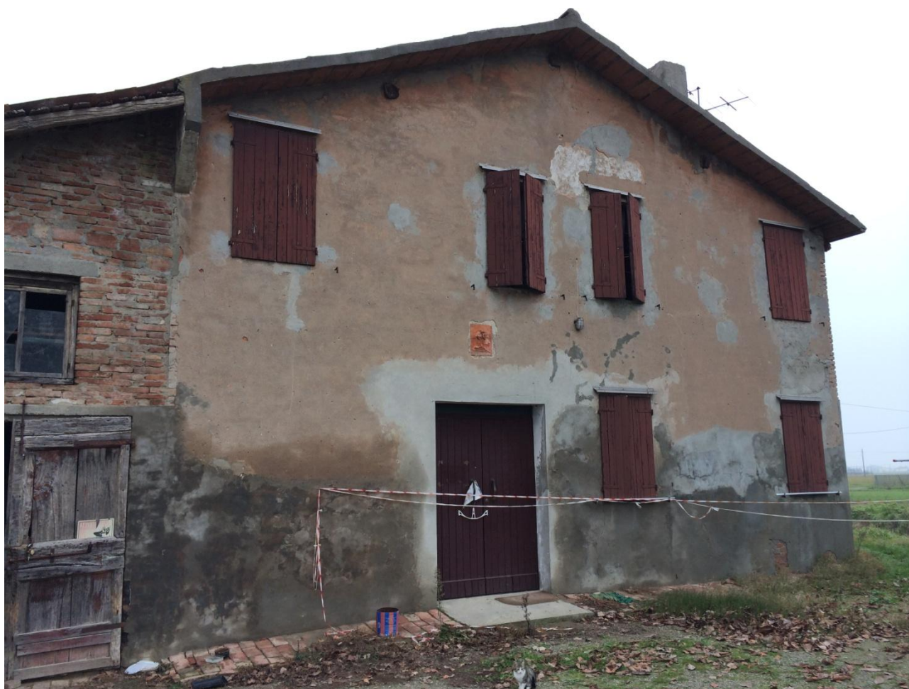
Fig. 1 - Vista della facciata sud
