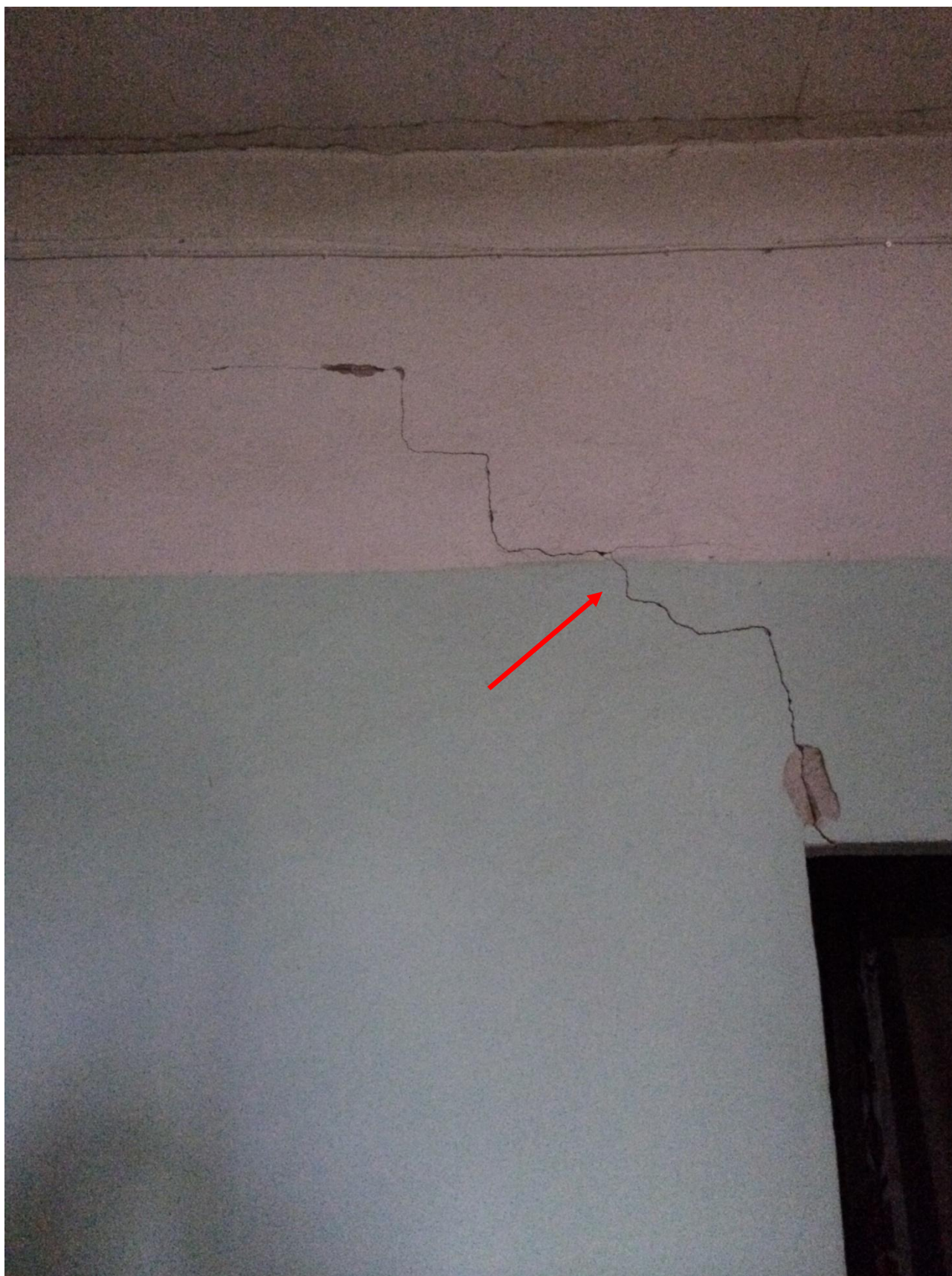
Fig. 63 – Lesione diagonale
