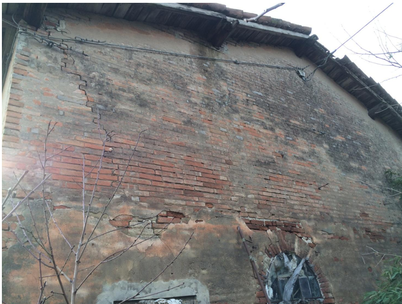
Fig. 19 – Vista della facciata nord
