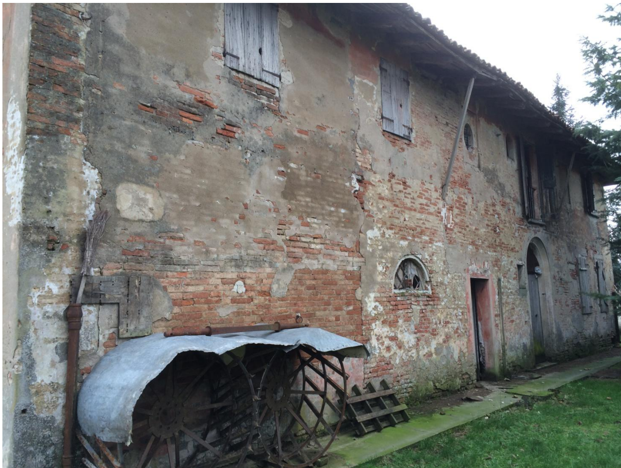
Fig. 21 - Vista della facciata nord
