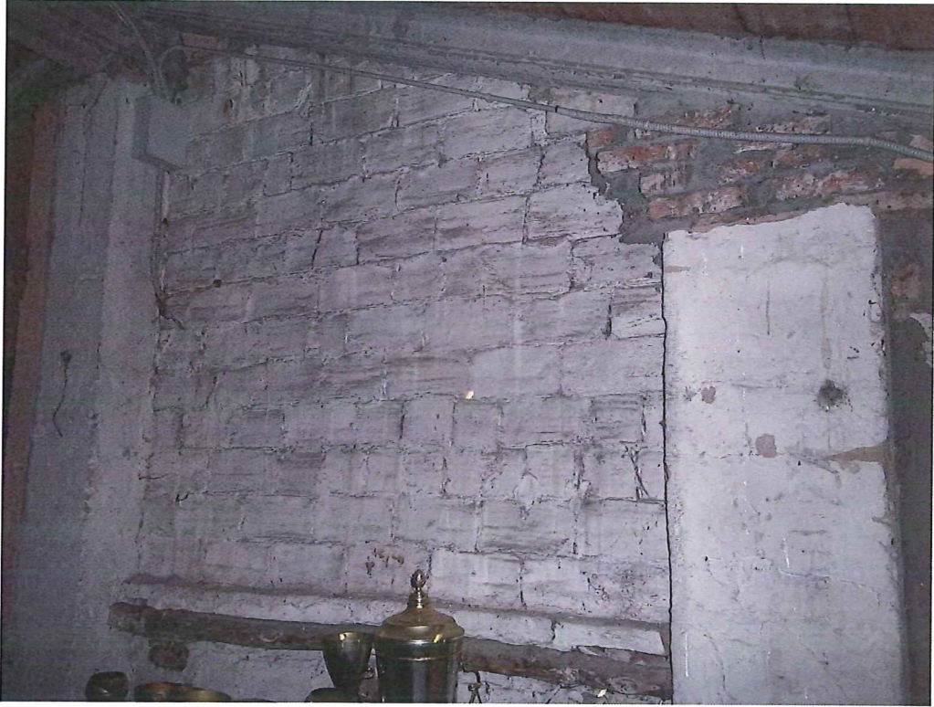
FOTO 34 = Interno – Particolare delle diverse composizioni delle murature
