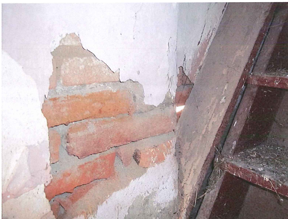
FOTO 12 = Interno – Dettaglio scale e muratura
