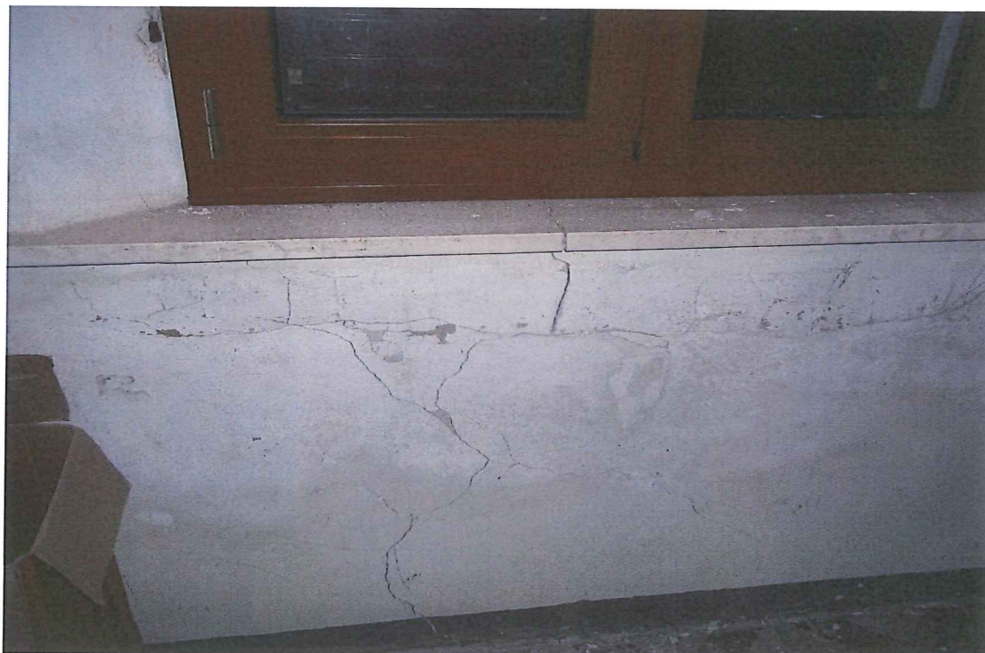
FOTO 43 = Interno – Lesione del bancale
