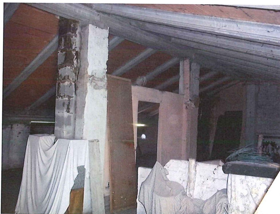
FOTO 31 = Interno – Pilastri in muratura del sottotetto
