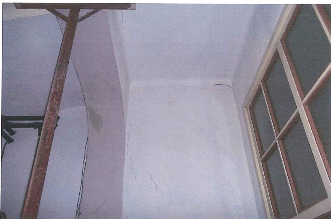
FOTO 34 = Interno – Arco della scala puntellato
