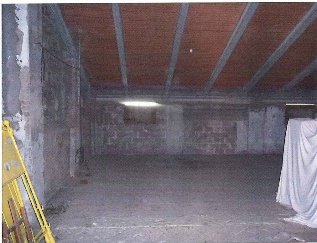
FOTO 32 = Interno – Particolare delle diverse composizioni delle murature
