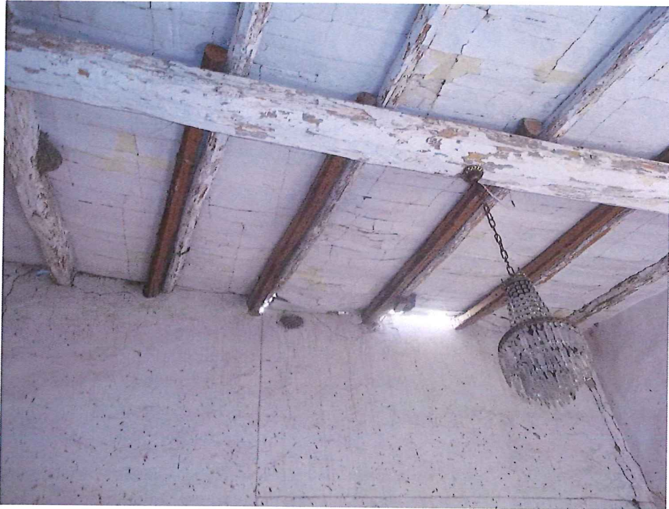
FOTO 13 = Interno – Dettaglio copertura civico 108
