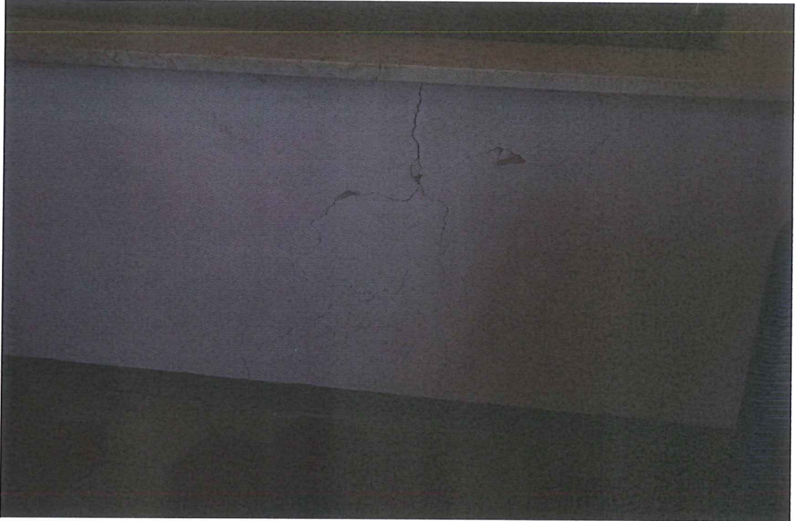
FOTO 40 = Interno – Lesione del bancale
