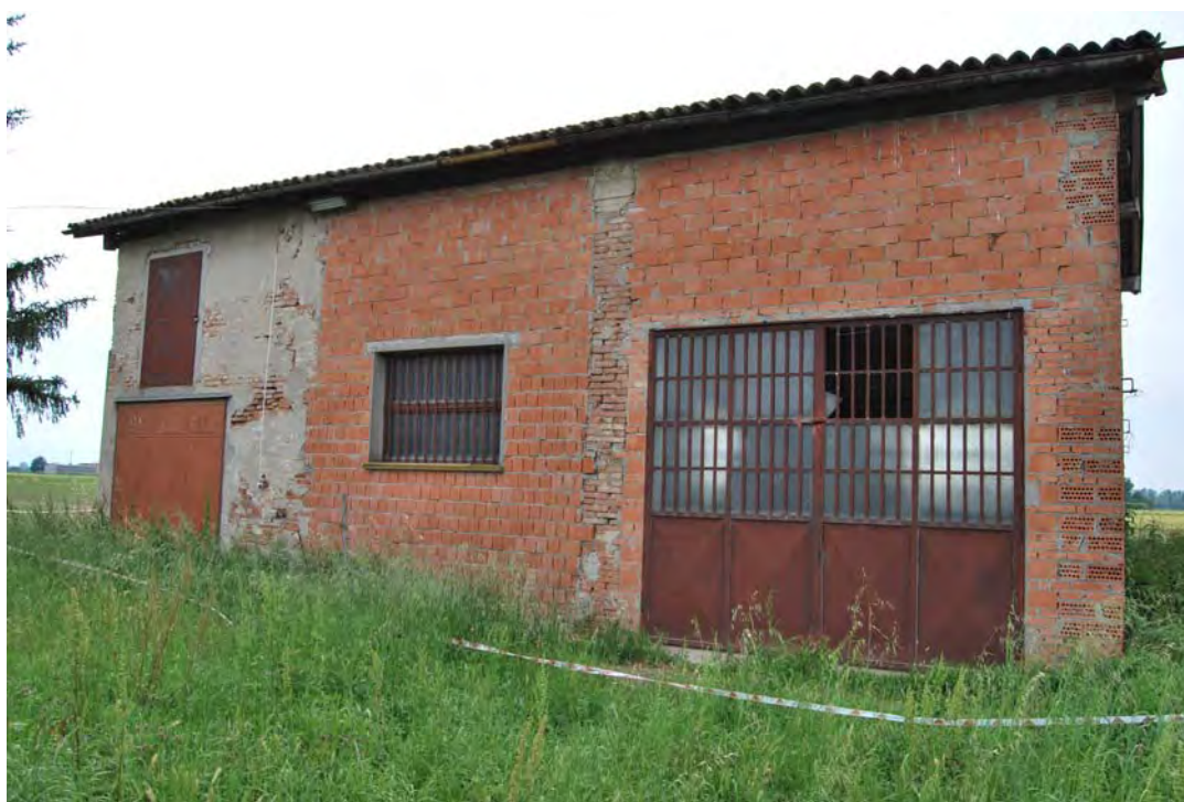
Vista del fabbricato dall'esterno con evidenza delle due porzioni sopra descritte.
