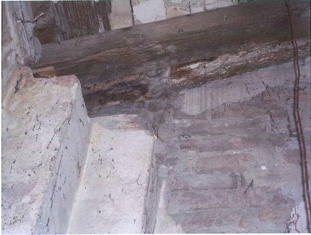
FOTO 15 = Interno – Dettaglio copertura civico 108
