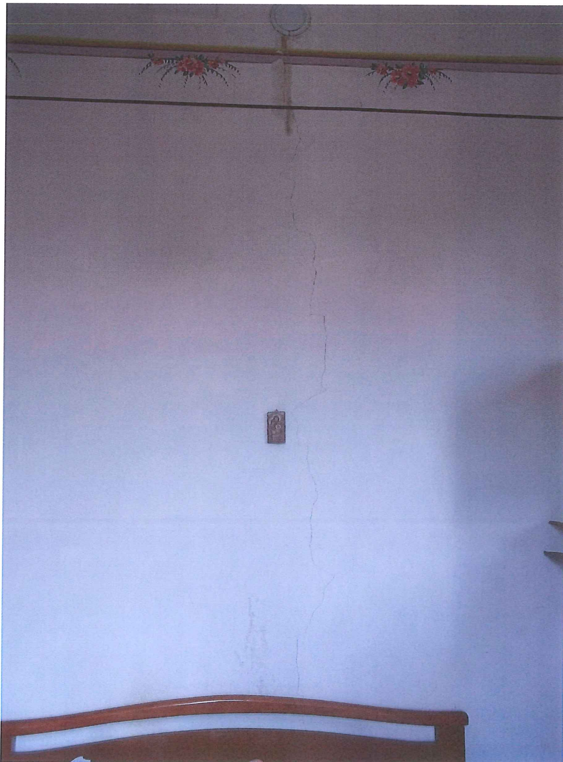
FOTO 50 = Interno – Lesione nei setti ad una testa
