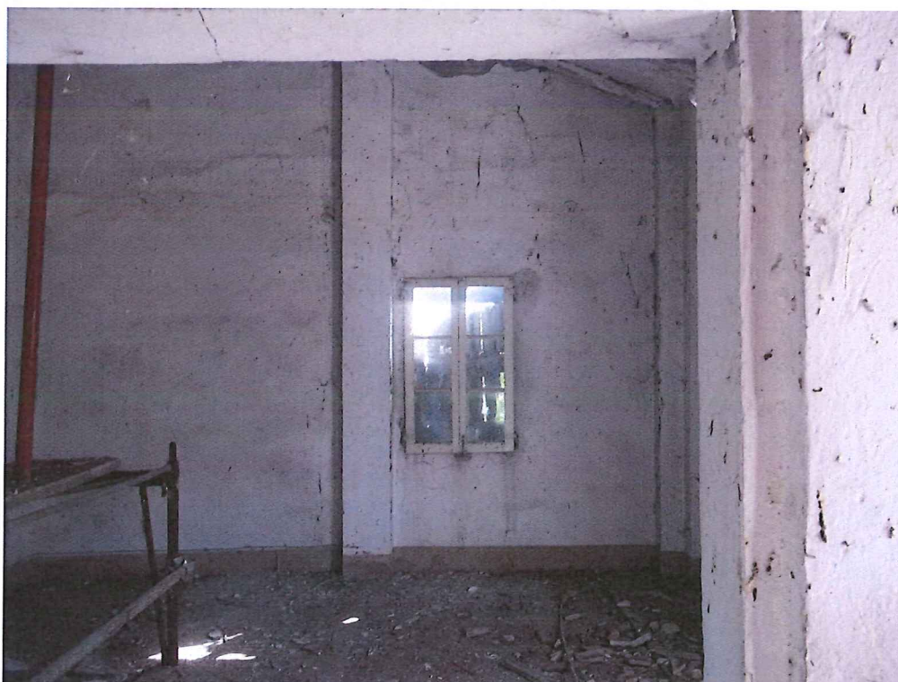
FOTO 18 = Interno – Lesione verticale d'angolo
