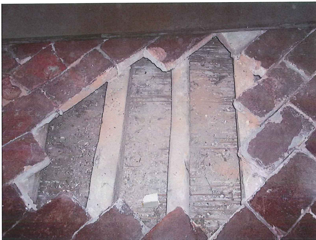
FOTO 28 = Particolare della composizione dei solai lignei
