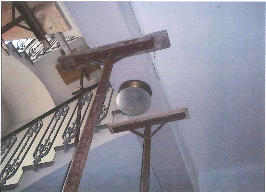
FOTO 33 = Interno – Arco della scala puntellato
