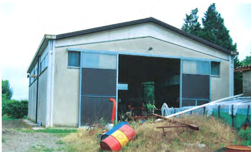
Fabbricato ad uso magazzino che subirà ampliamento per la ricostruzione dei fabbricati ad uso deposito.
