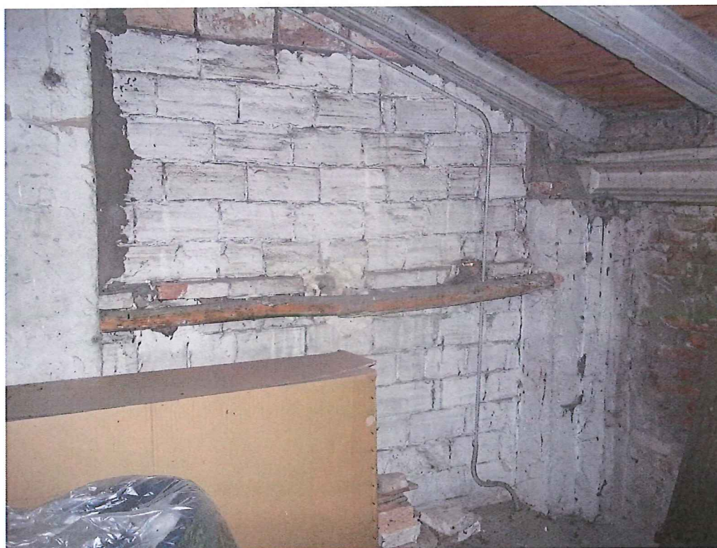
FOTO 33 = Interno – Particolare delle diverse composizioni delle murature
