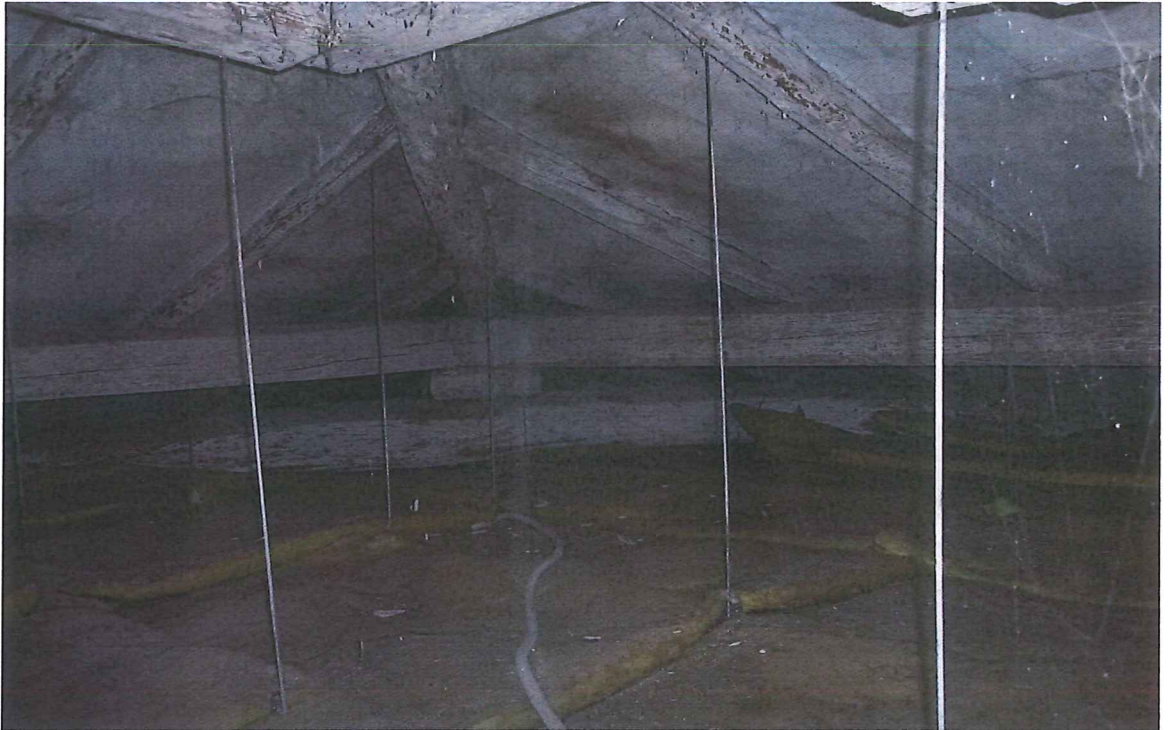
FOTO 53 = Dettaglio della copertura
