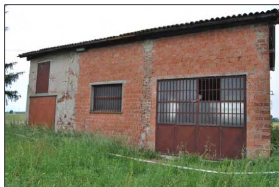
Foto magazzino: corte n. 378 da delocalizzare nella corte n. 384
