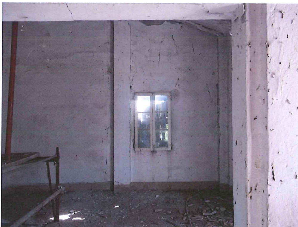
FOTO 18 = Interno – Lesione verticale d'angolo
