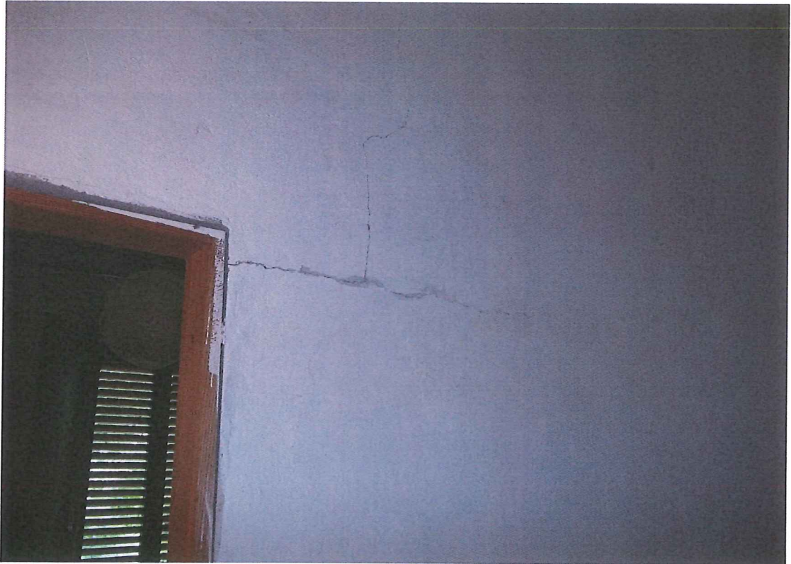
FOTO 44 = Interno – Lesione nei setti ad una testa
