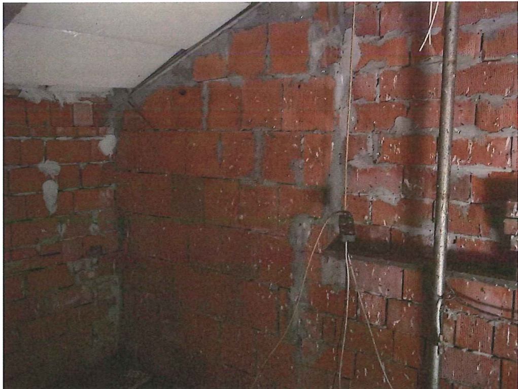
FOTO 26 = Interno – Particolare delle diverse composizioni delle murature
