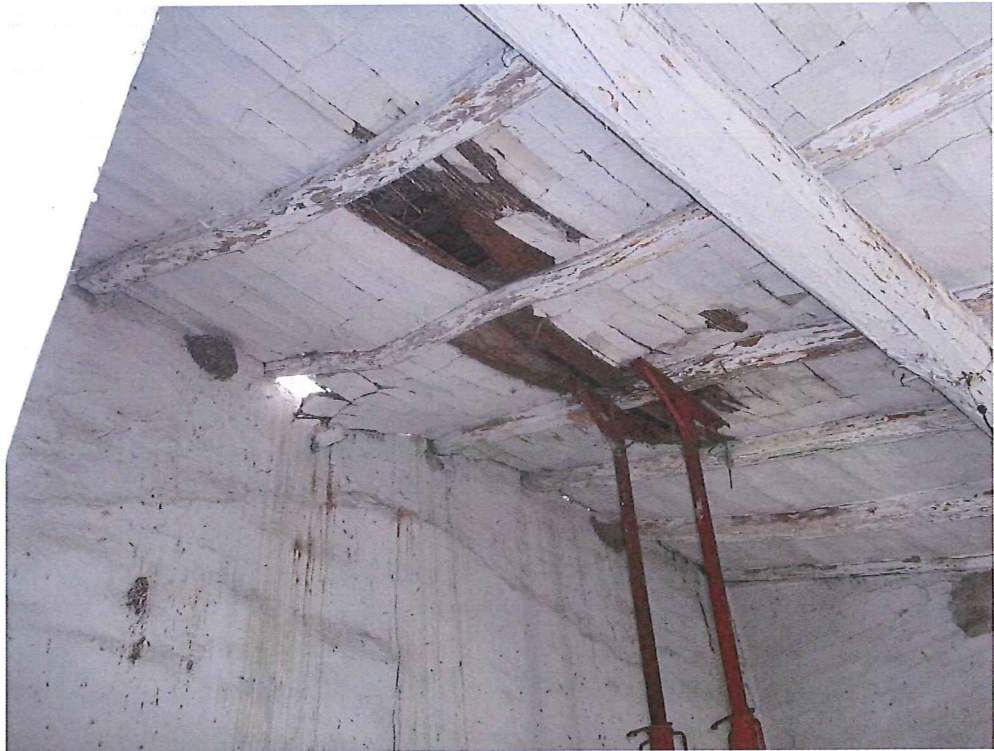
FOTO 16 = Interno – Dettaglio copertura civico 108
