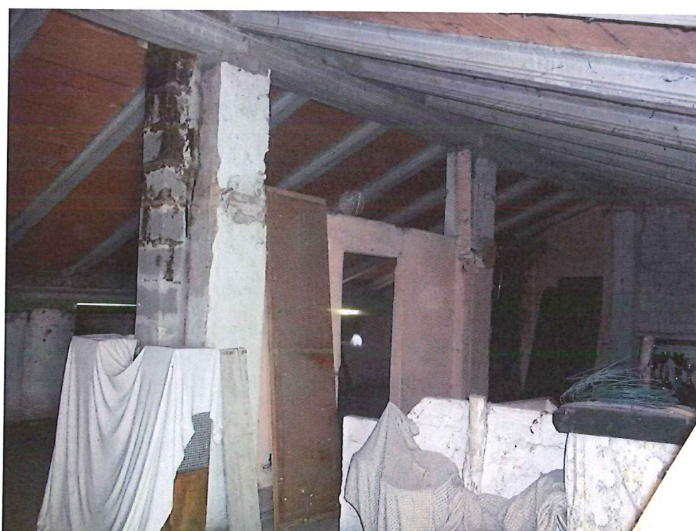
FOTO 31 = Interno – Pilastri in muratura del sottotetto
