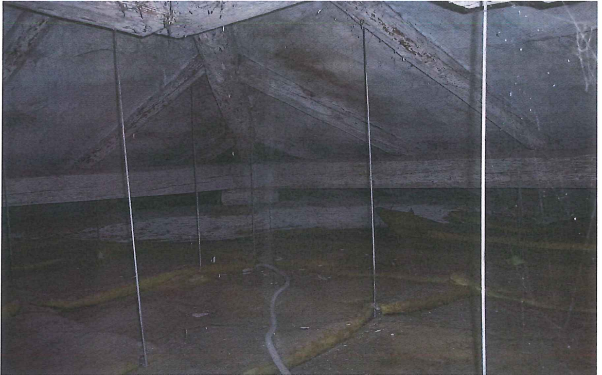
FOTO 53 = Dettaglio della copertura
