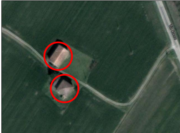
Vista aerea corte. n. 378 via Cucco n. 16
