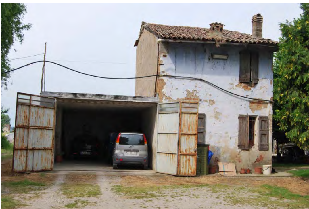
Vista del deposito posto più a nord.
