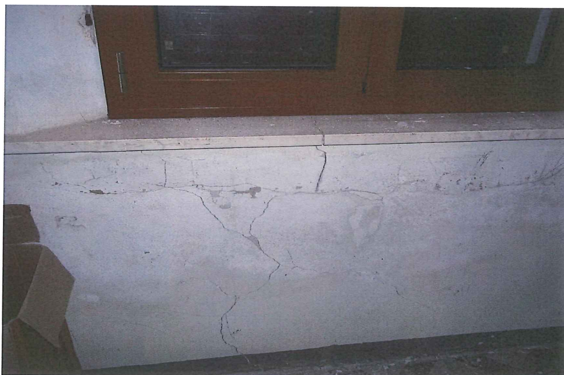
FOTO 43 = Interno – Lesione del bancale
