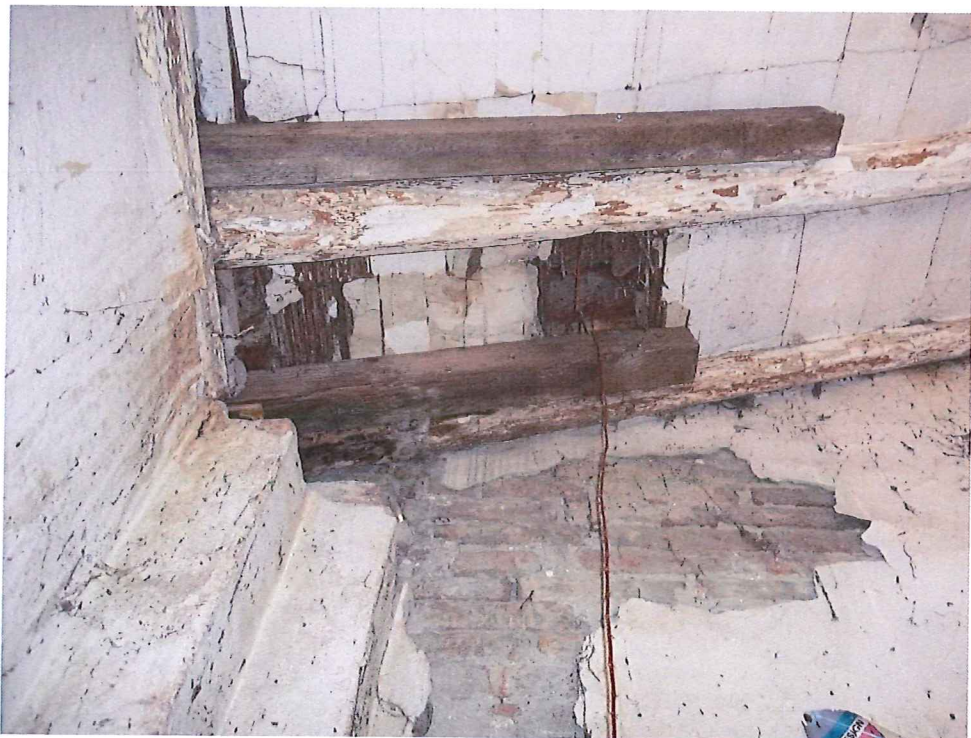
FOTO 14 =Interno – Dettaglio copertura civico 108
