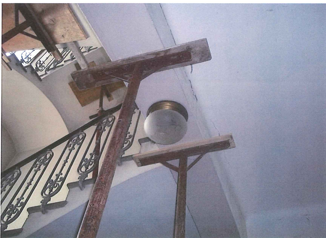
FOTO 33 = Interno – Arco della scala puntellato
