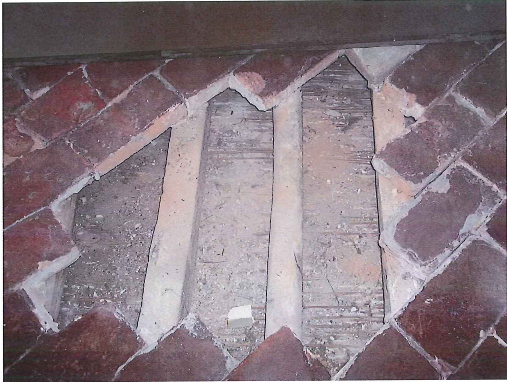
FOTO 28 = Particolare della composizione dei solai lignei
