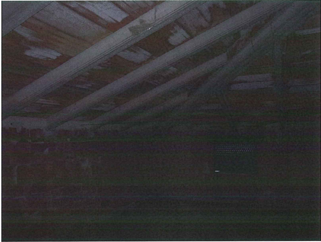
FOTO 25 = Interno – Particolare copertura in varesa – Civici 110-112
