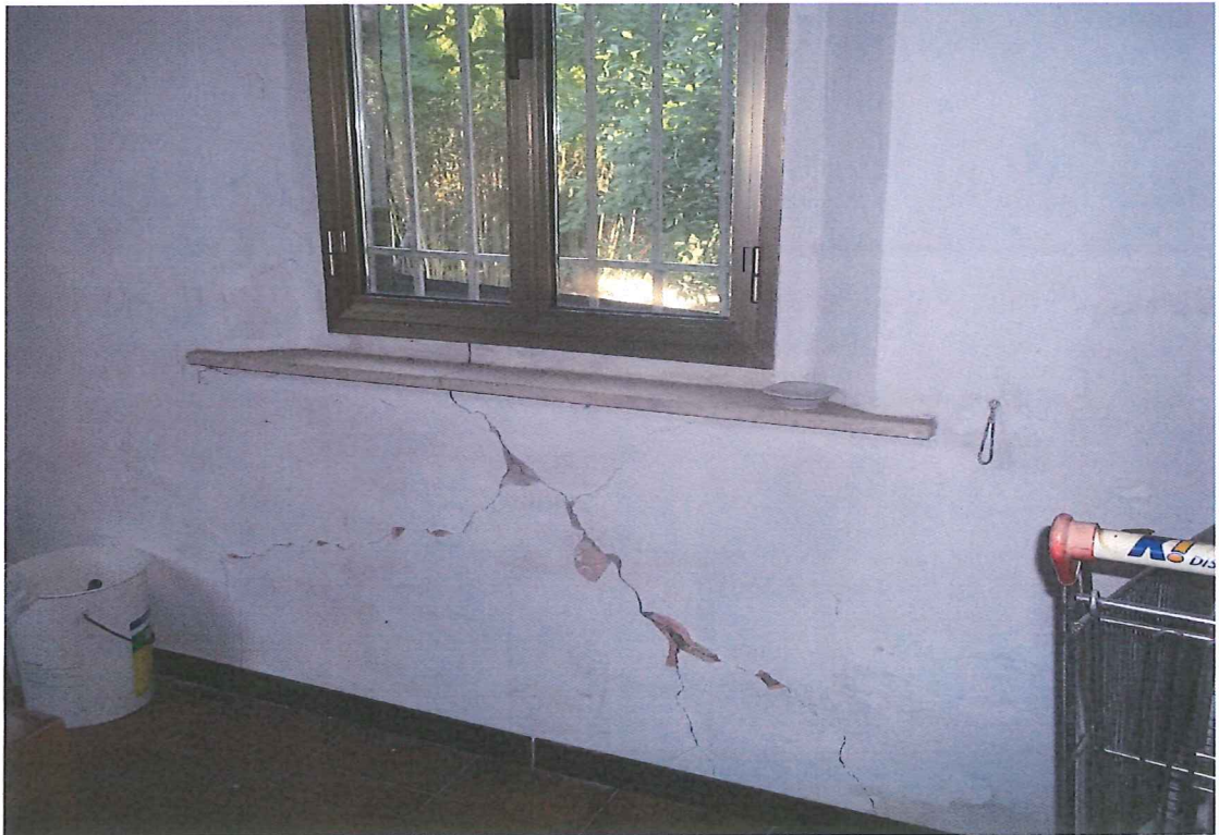
FOTO 25 = Interno – Lesione del bancale
