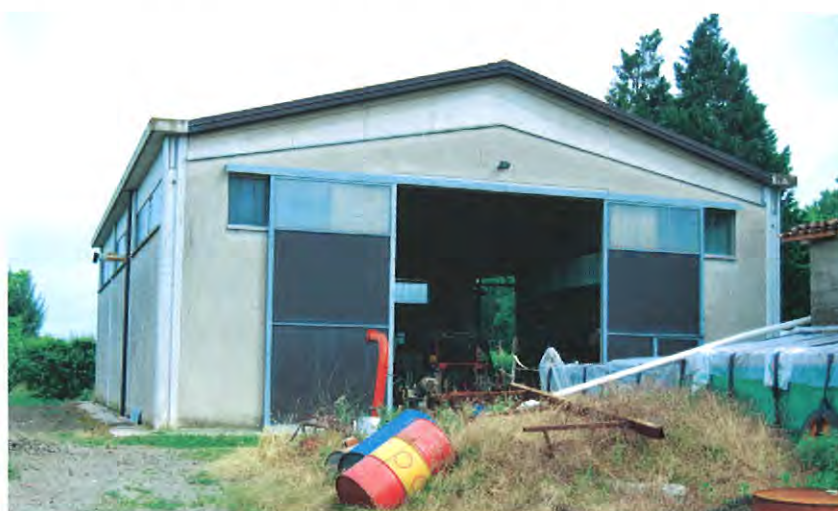
Fabbricato ad uso magazzino che subirà ampliamento per la ricostruzione dei fabbricati ad uso deposito.
