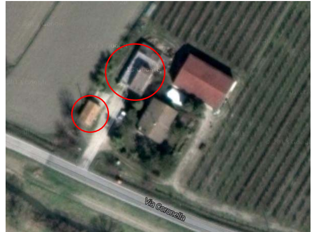
Vista aerea corte. 384 via Coronella n. 85
