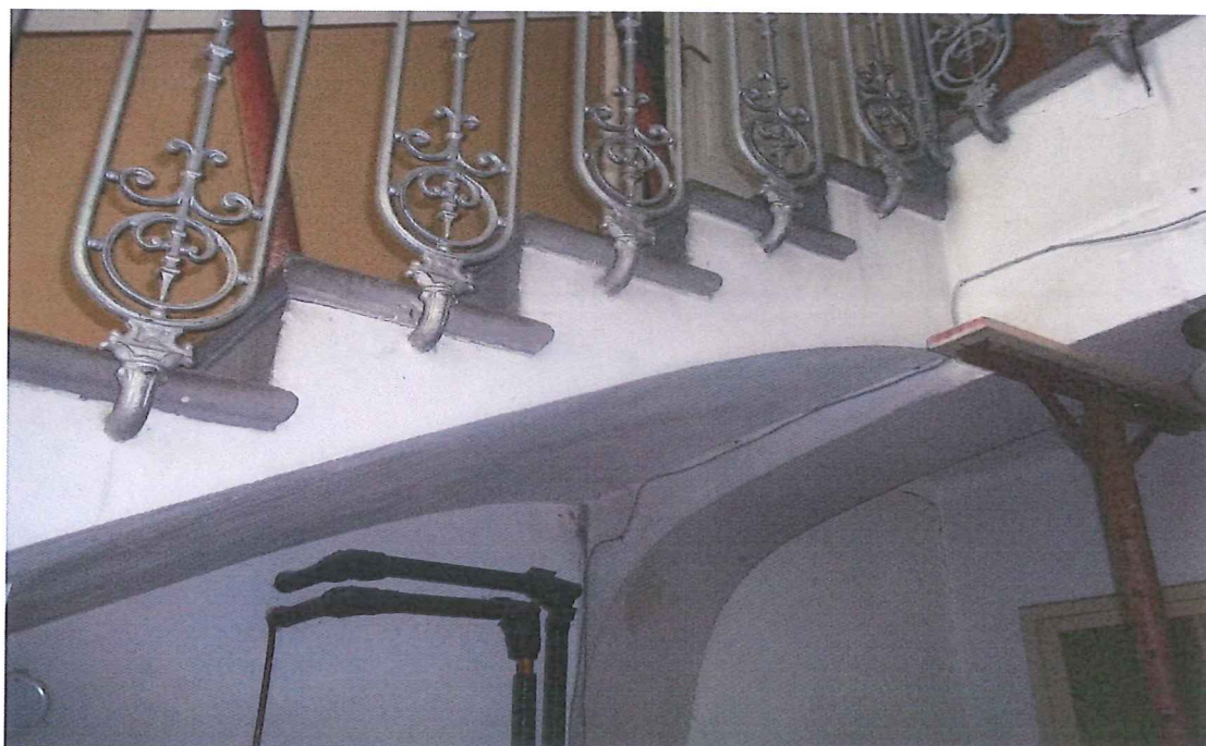
FOTO 35 =Interno – Arco della scala puntellato
