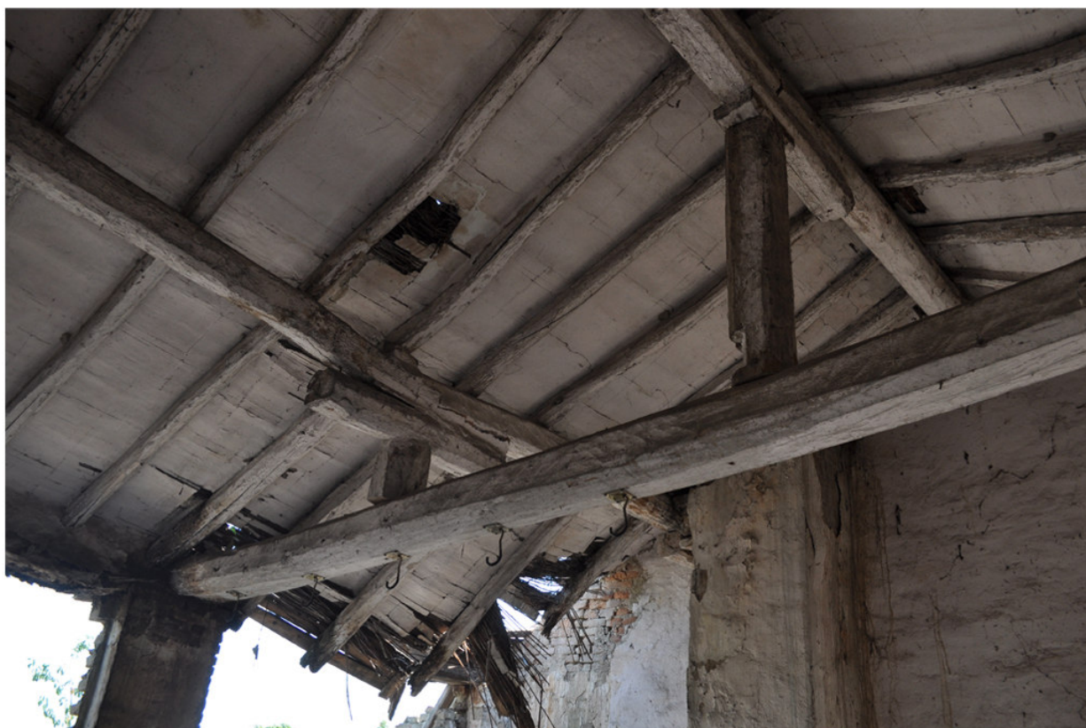
Foto 9. Vista della copertura
