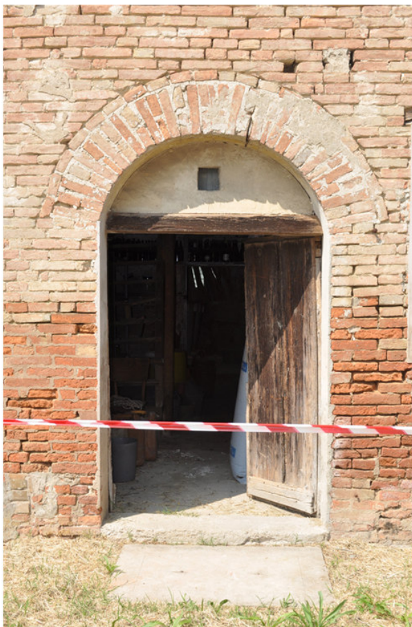
Foto 4. Vista della porta d'ingresso principale
