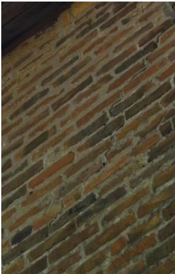
ESEMPIO DI LESIONE CONCENTRATA PASSANTE
