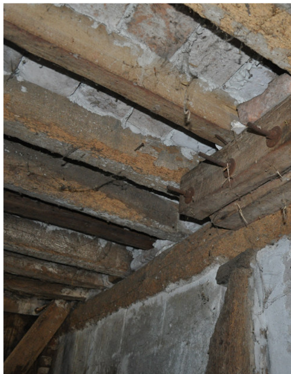
Foto 8. Vista del solaio interpiano
