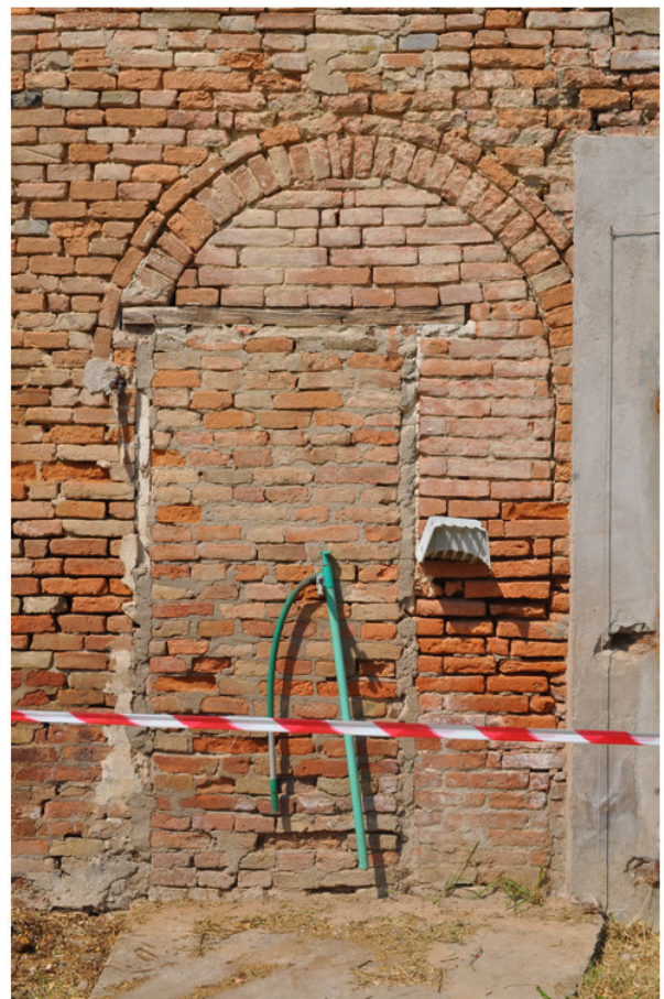
Foto 5. Vista di una porta tamponata
