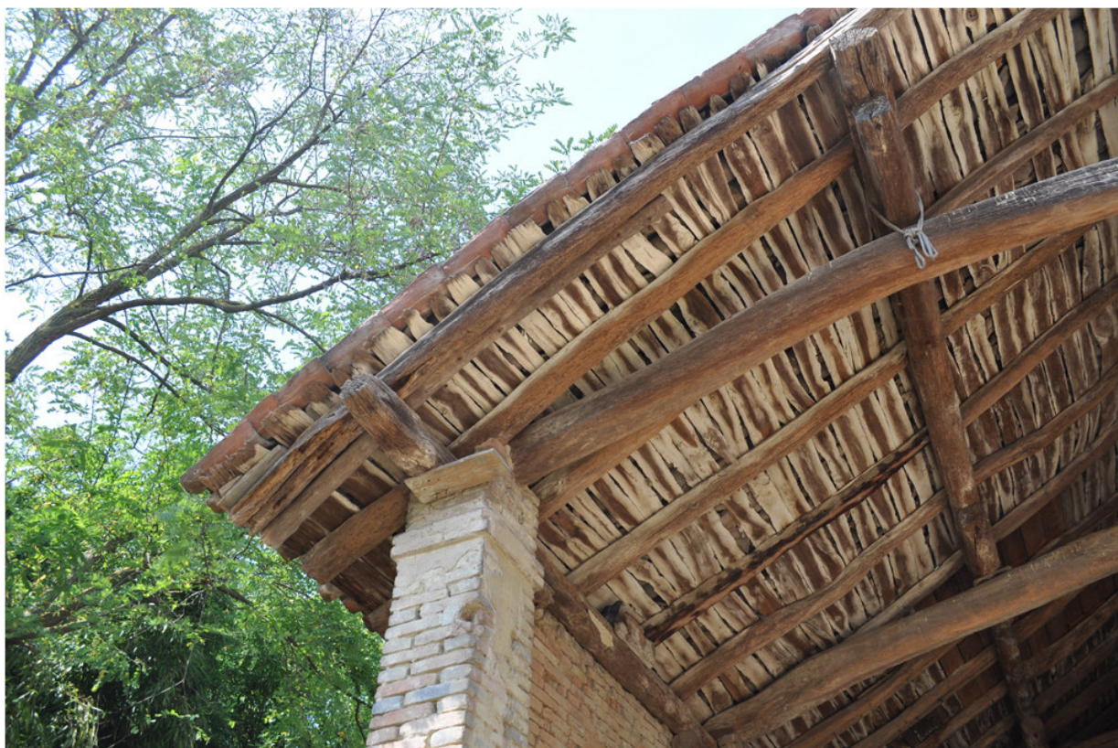
Foto 7. Vista della copertura in legno
