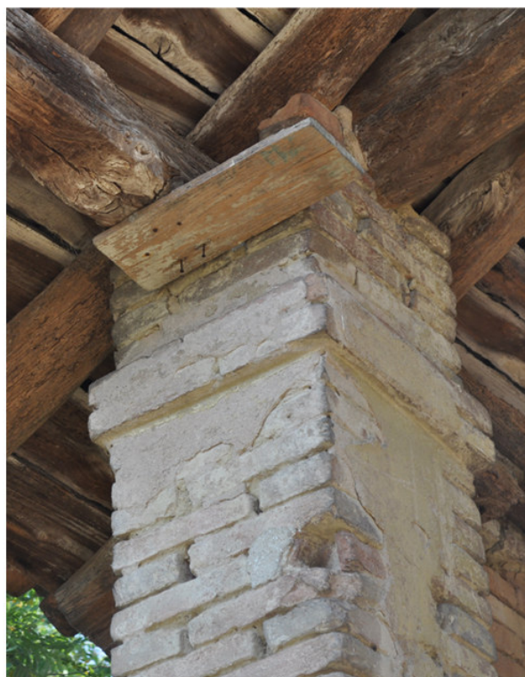
Foto 6. Vista di un particolare del pilastro
