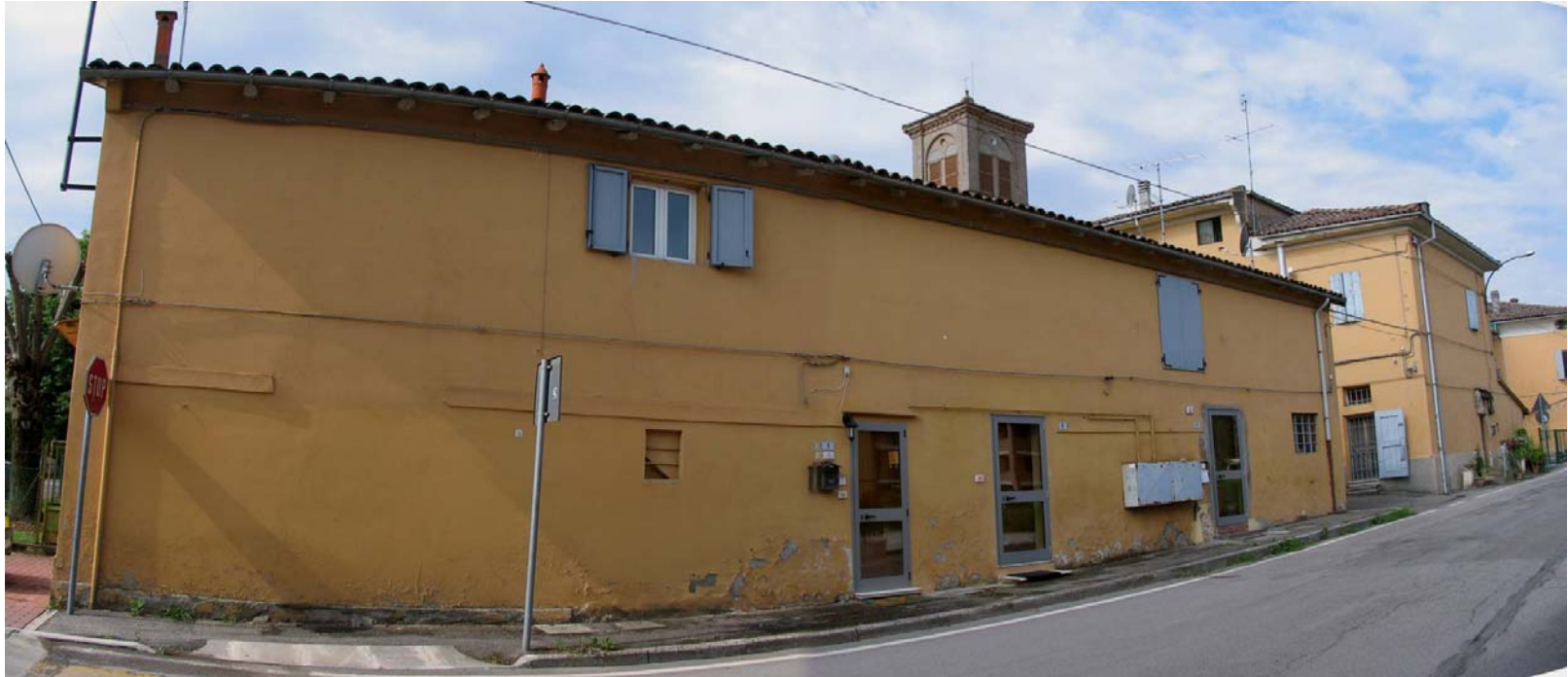
3/I- Il lato di Via Canale determinato dagli edifici del complesso della pieve.
