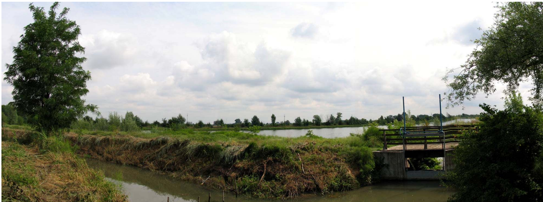
5/1- L'opera di canalizzazione, gli argini, la paratoie e gli specchi d'acqua delle ex risaie.
